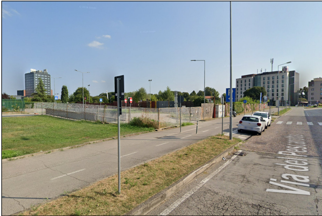
Figura 6. Vista da via del Pescarotto dell'area di intervento allo stato di fatto (fonte: https://www.google.com/maps/ ).
