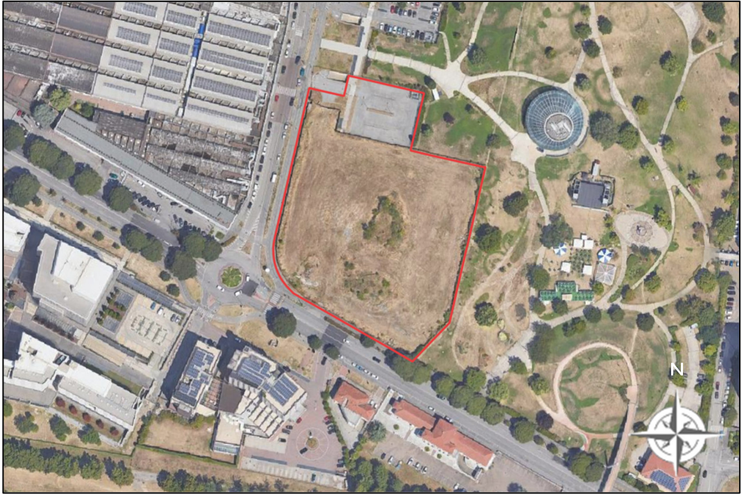
Figura 2. Inquadramento dell'area oggetto di studio.
