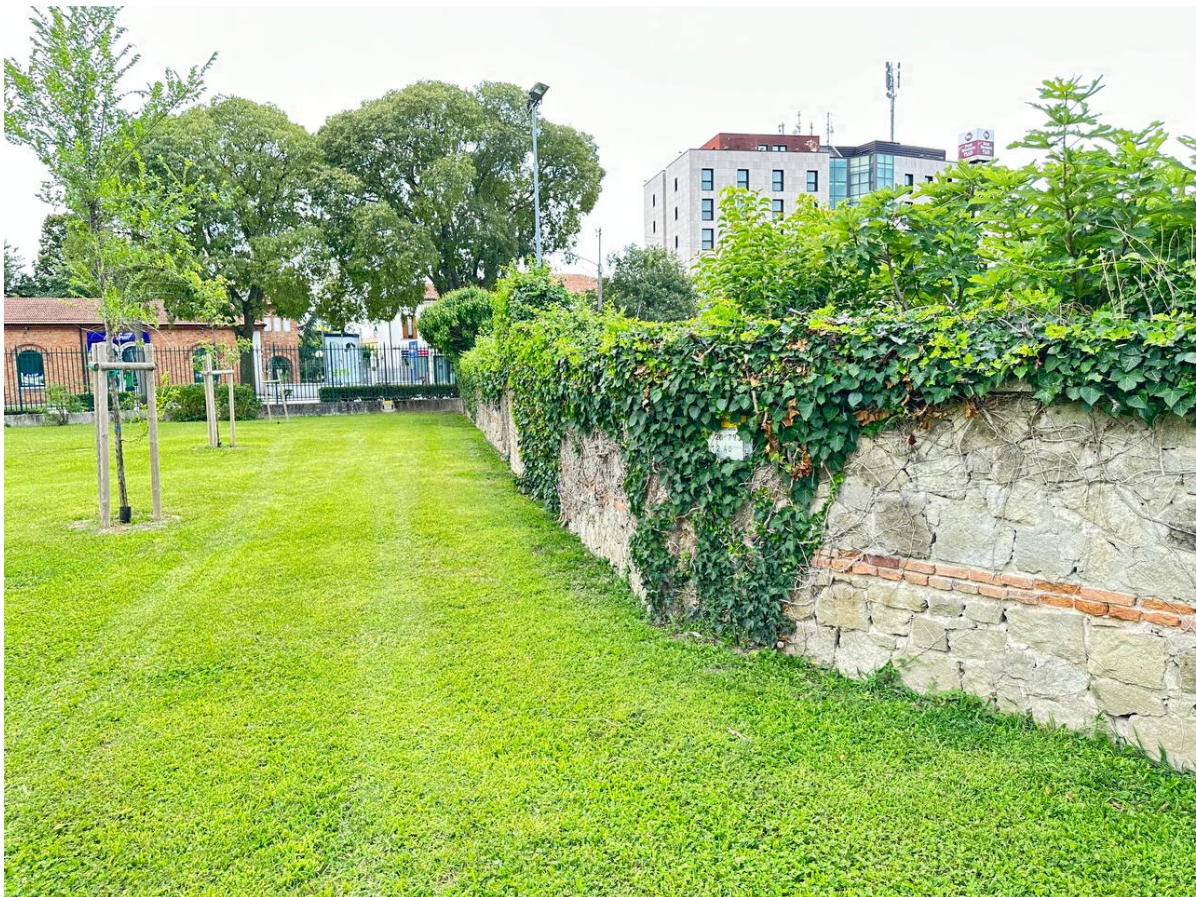
Foto 4 – vista su muro di confine lotto con parco
