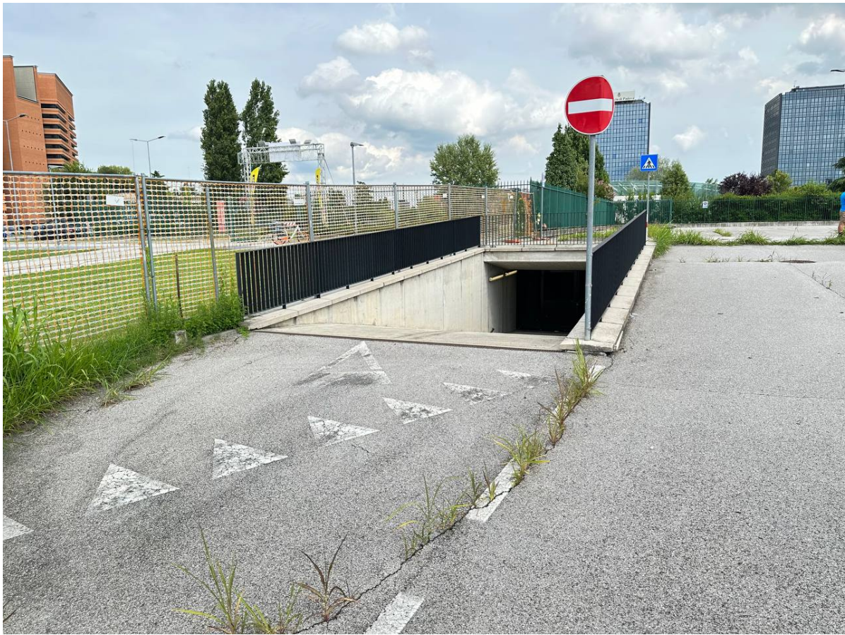
Foto 1 – vista rampa di accesso piano interrato
