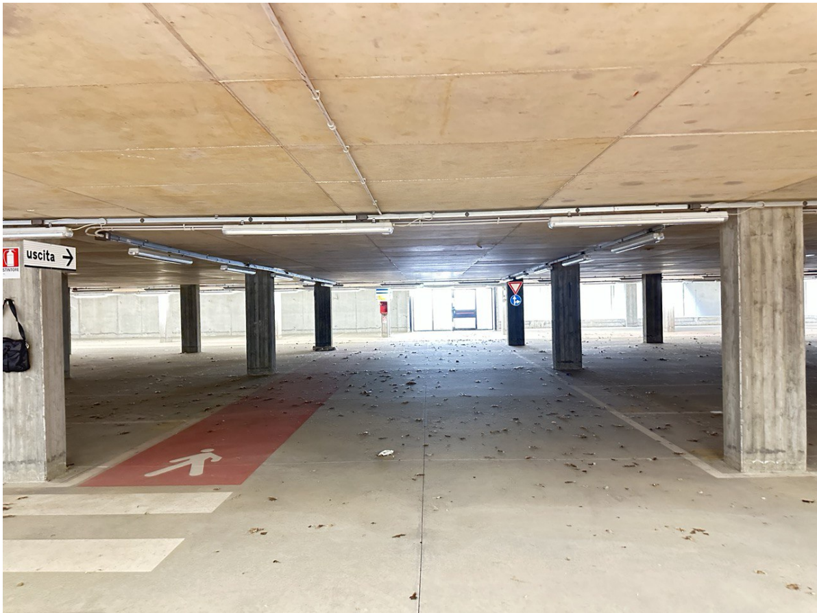
Foto 11 – vista parcheggio piano interrato
