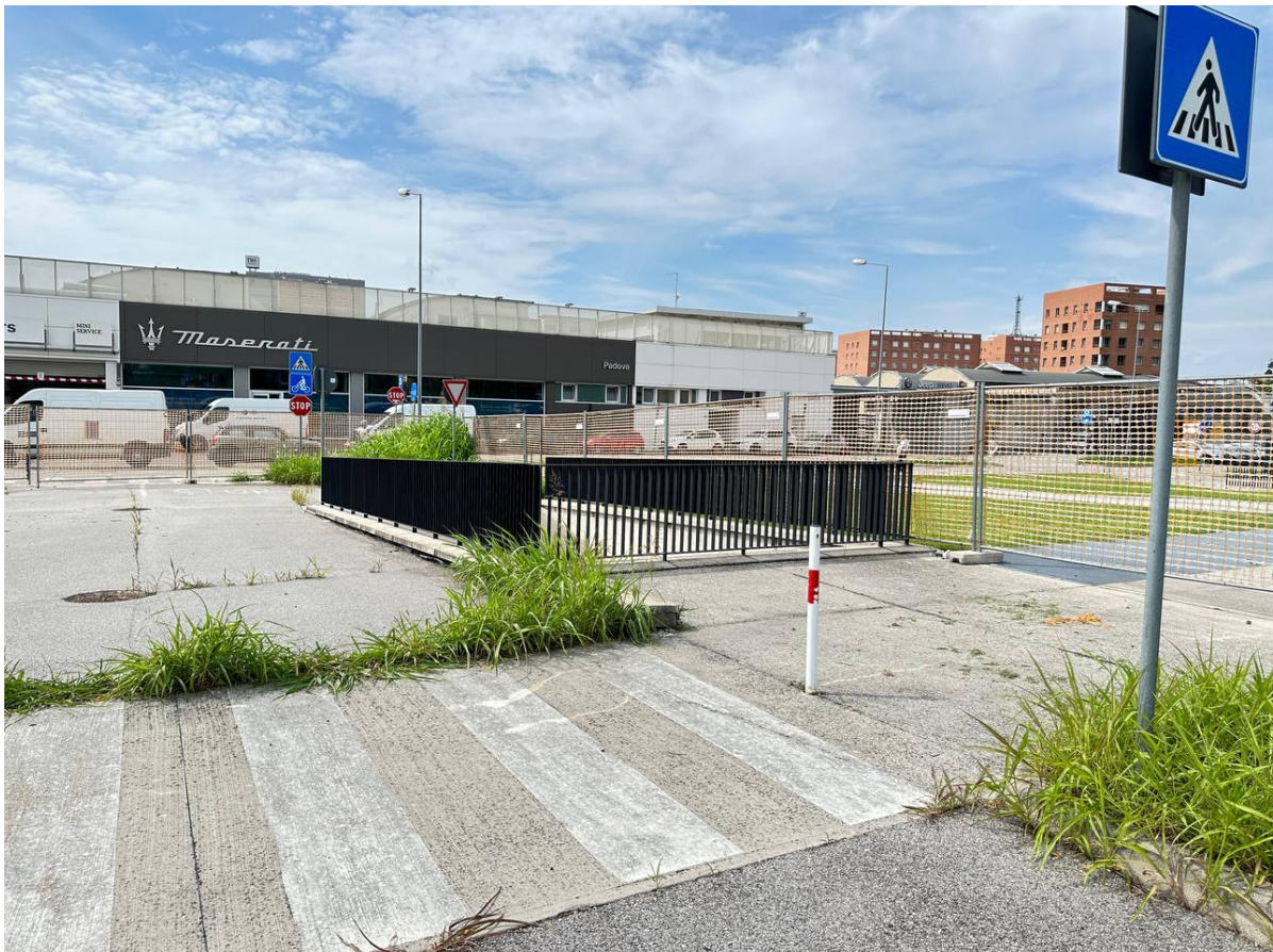
Foto 2 – vista su retro di rampa di accesso piano interrato
