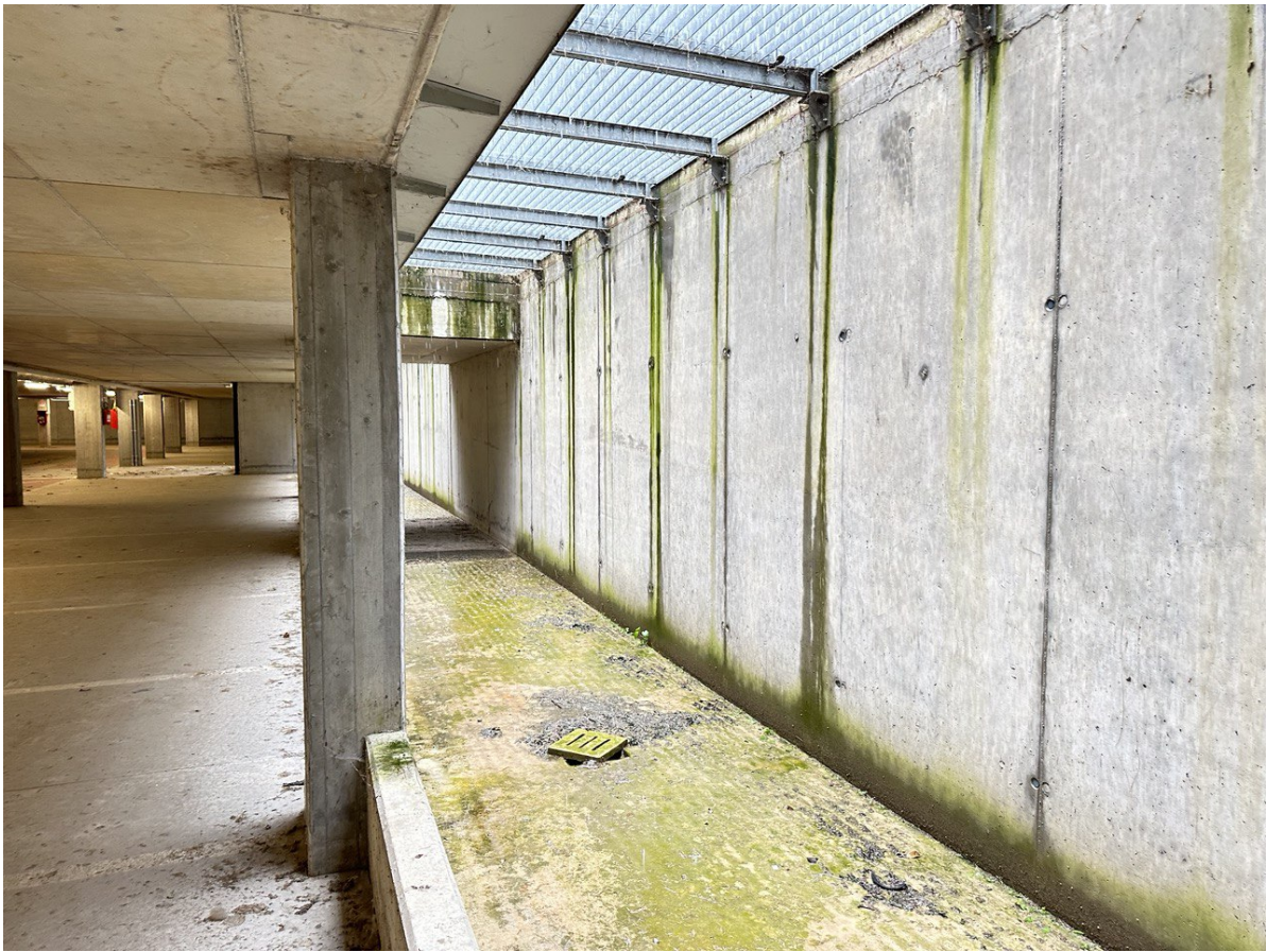
Foto 9 – vista parcheggio piano interrato
