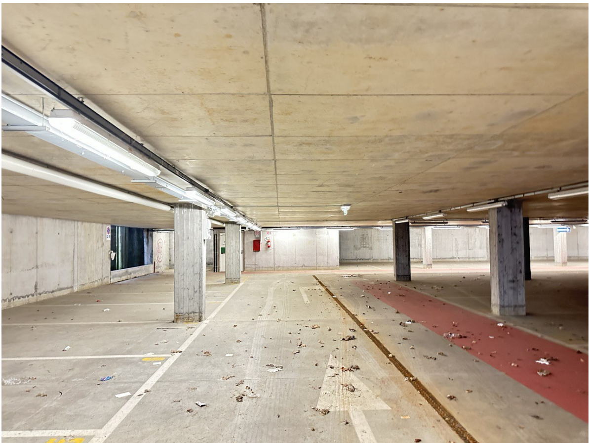
Foto 10 – vista parcheggio piano interrato
