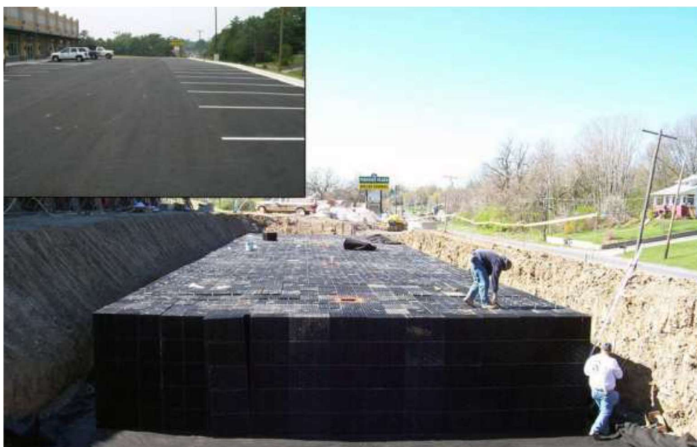
Figura 16- Cella modulare in materiale plastico in fase di montaggio
