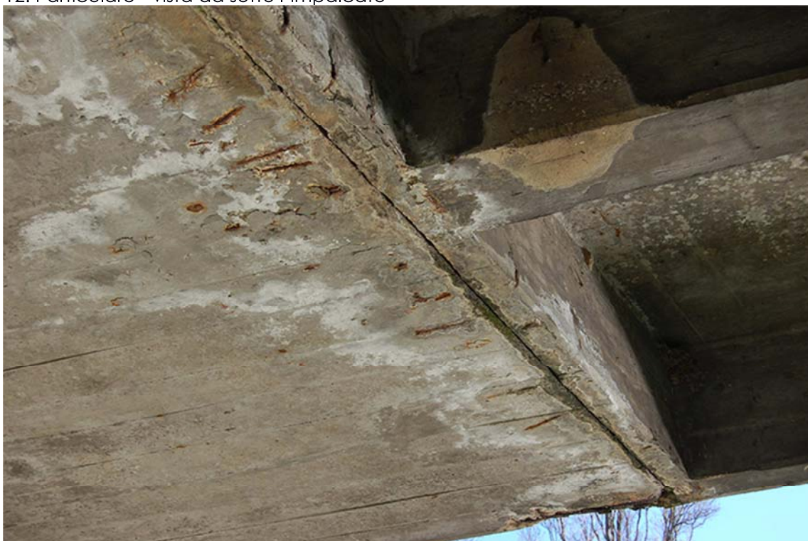
13. Vista dettaglio da sotto l'impalcato – sella Gerber
