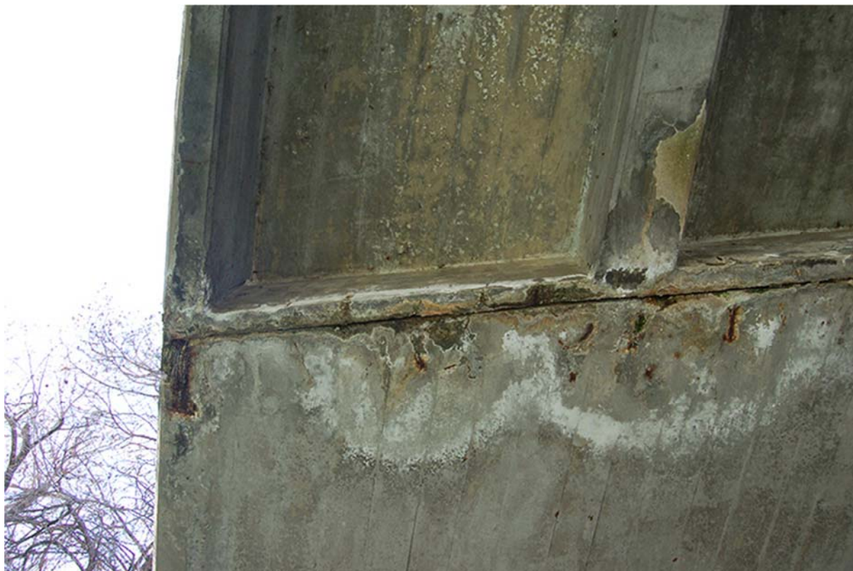
18. Dettaglio sella Gerber lato destro – vista da sotto l'impalcato
