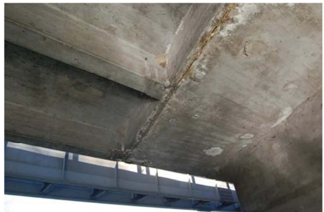
Vista di dettaglio sella Gerber
