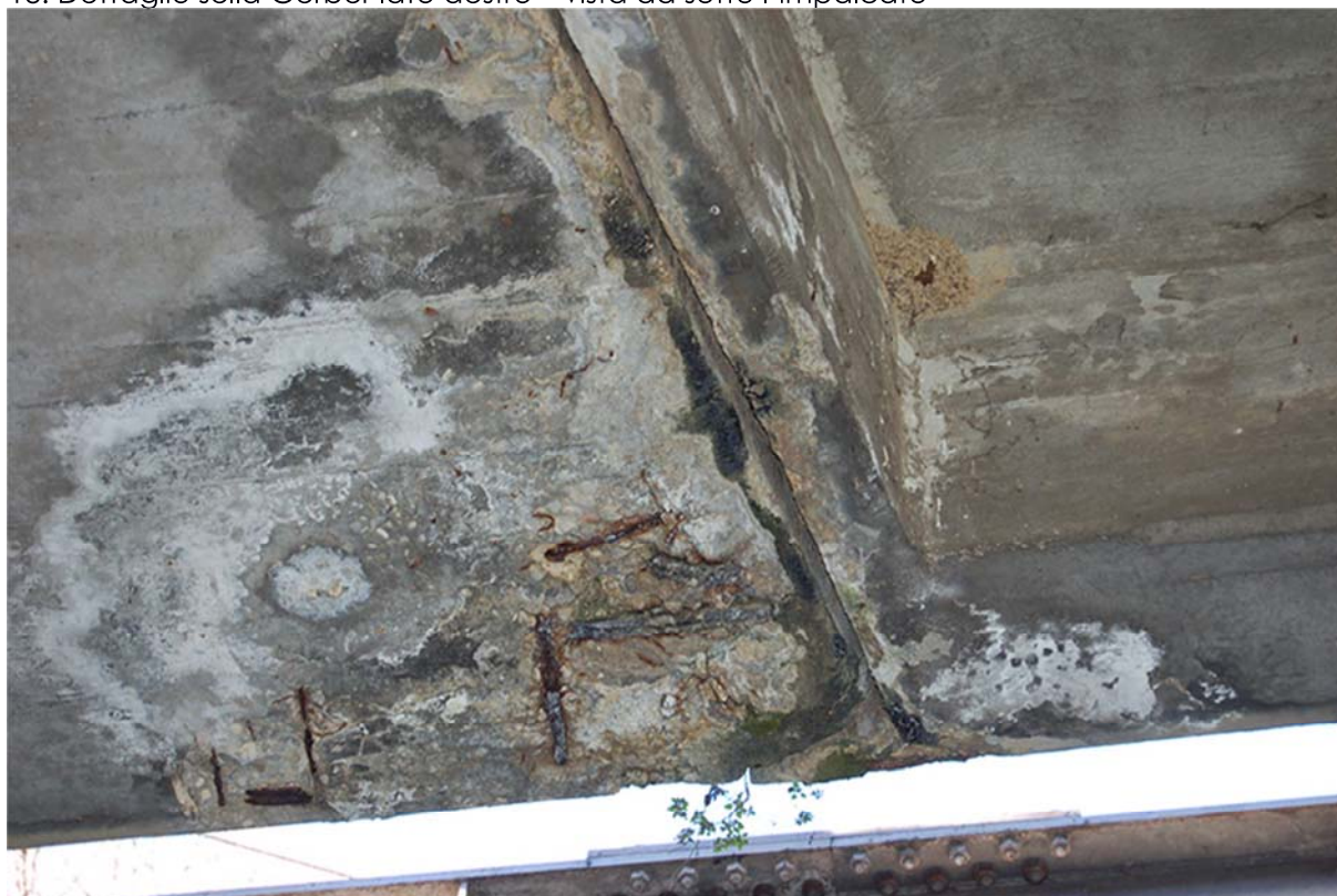
19. Dettagli ferri sotto l' impalcato – sella Gerber
