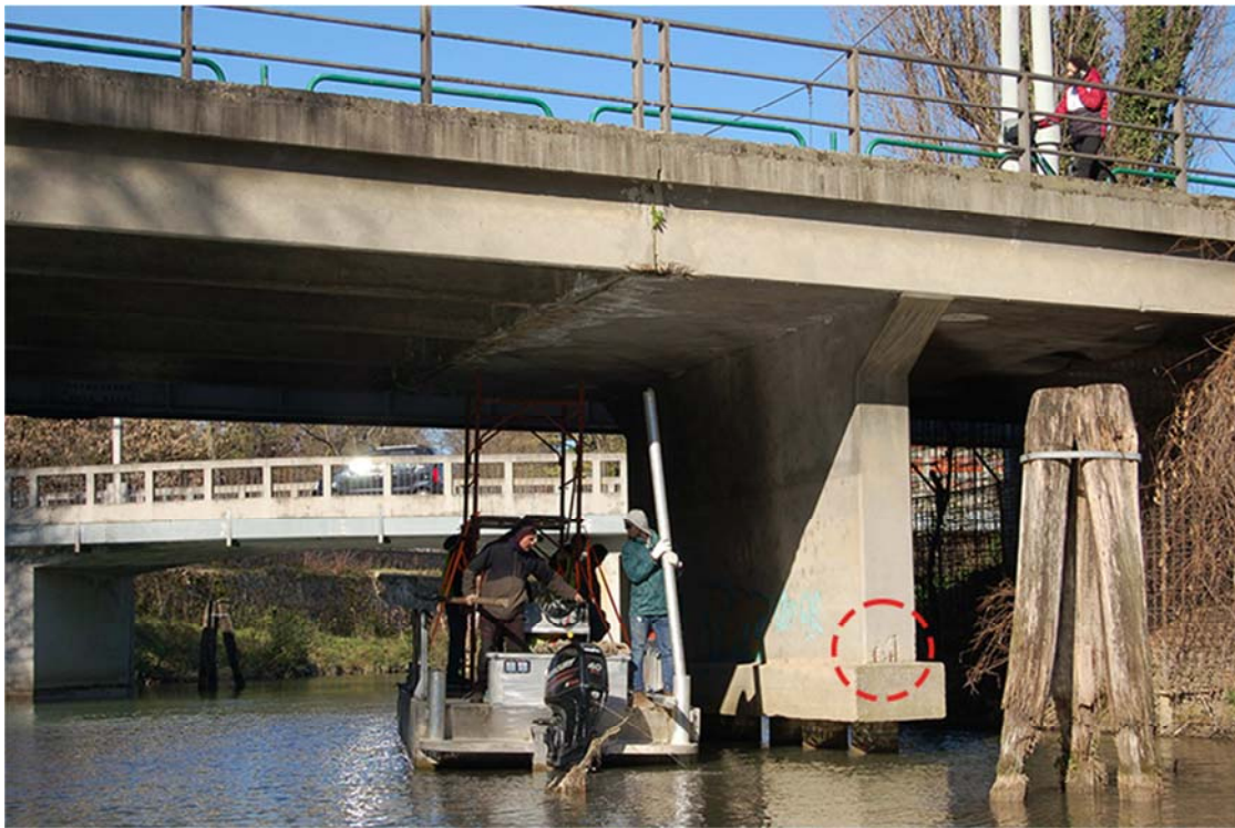
10. Vista dettaglio ferri esposti alla base della pila sinistra
