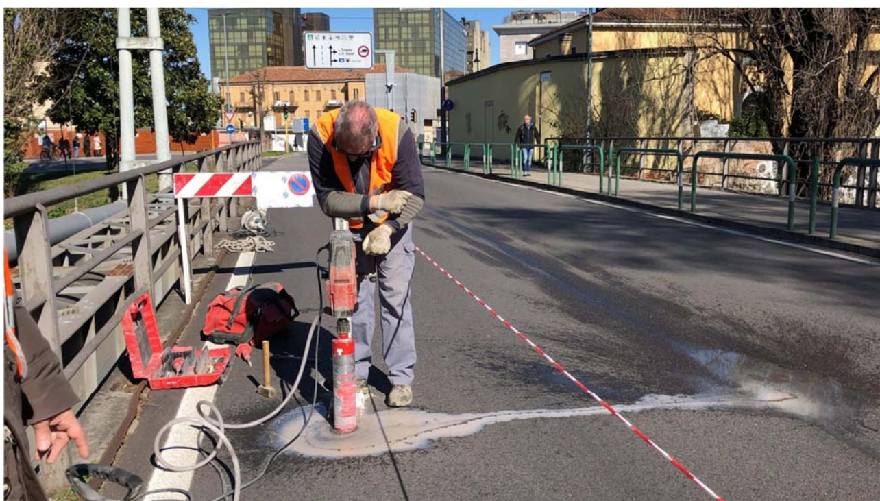
Realizzazione dell'estrazione del provino tramite carotatrice
