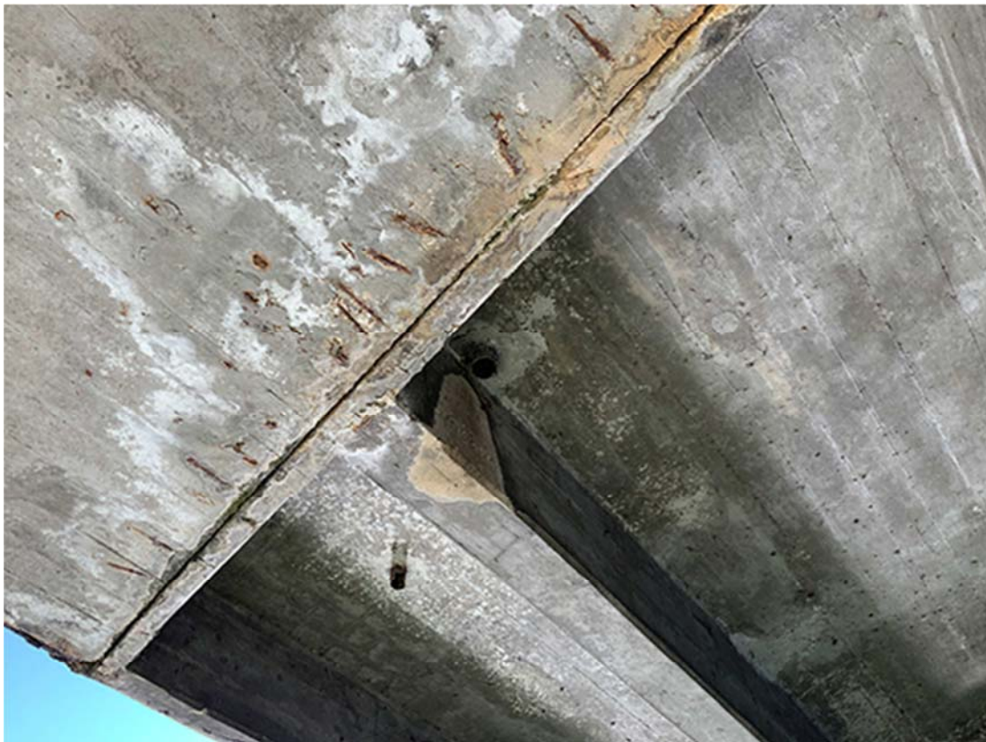
14. Vista dettagli sotto l'impalcato – sella Gerber
