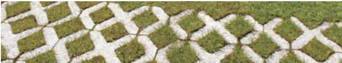
Figura 16 - Pavimentazione adatta alla realizzazione di parcheggi drenanti
