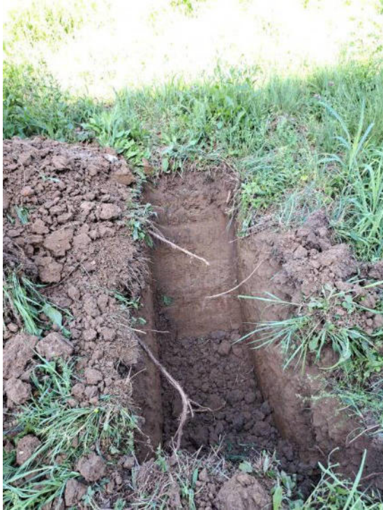
Foto trincea T1
