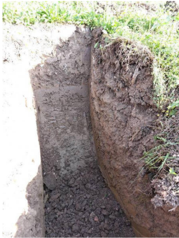
Foto trincea T7
