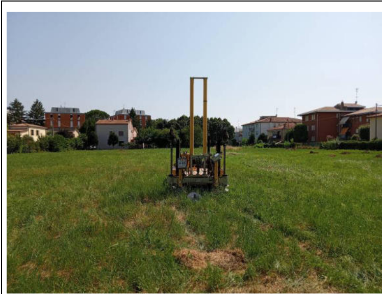
Esecuzione della prova CPTU1
