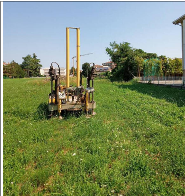
Esecuzione della prova CPTU2
