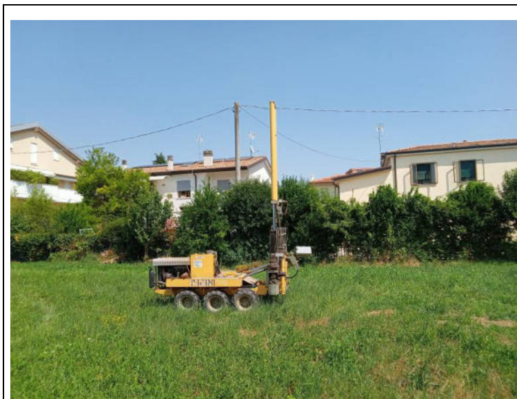
Esecuzione della prova CPTU4
