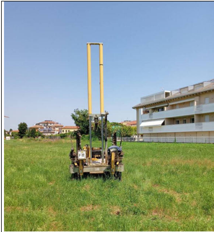
Esecuzione della prova CPTU3
