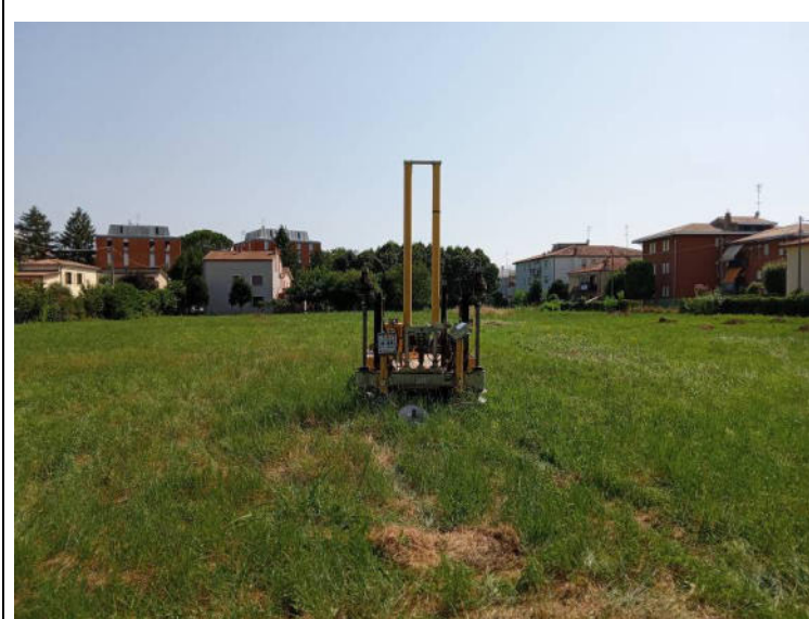
Esecuzione della prova CPTU1
