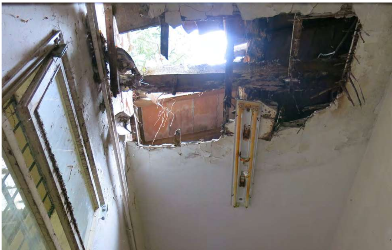
Immagine interno - Lato Est particolare tetto
