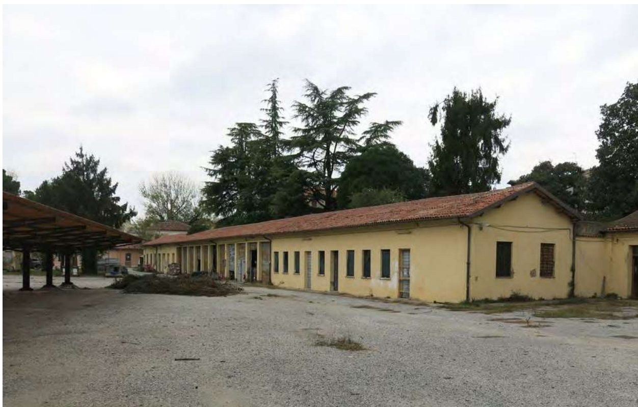
Immagine esterno - Prospetti Sud - Est
