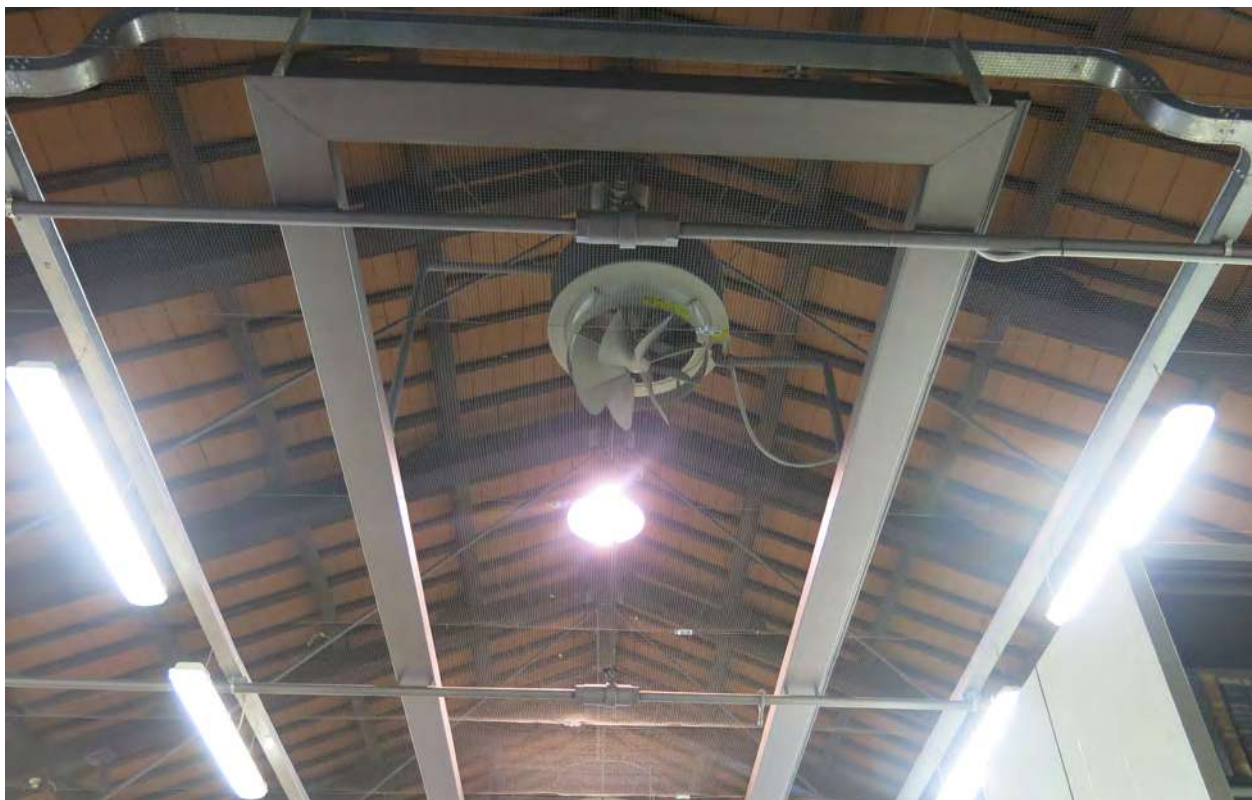
Immagine interno - Copertura
