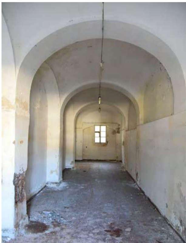
Immagini interno - Piano terra
