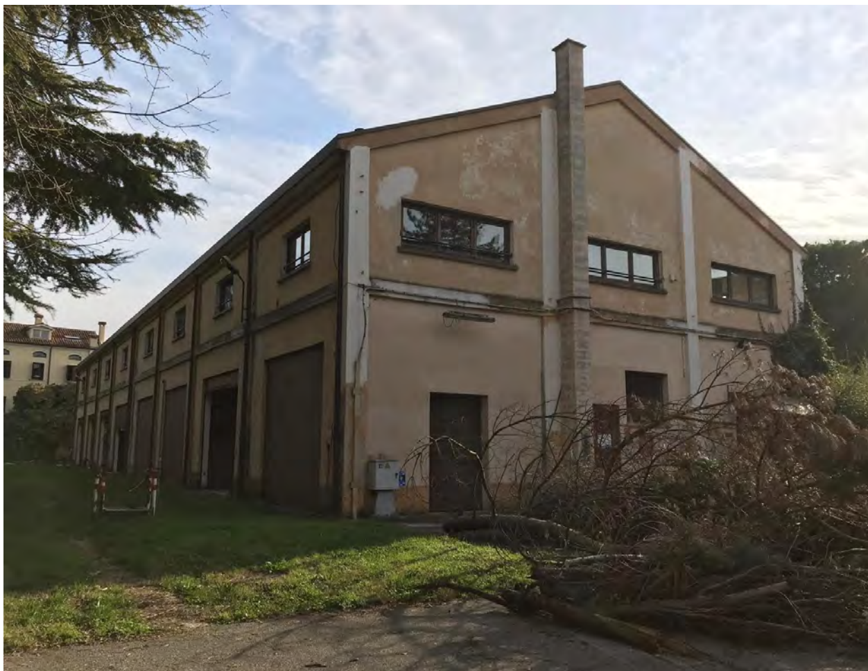
Immagine esterno - Prospetto Nord-Ovest
