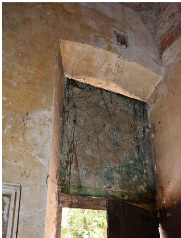
Immagine interno - Piano terra
