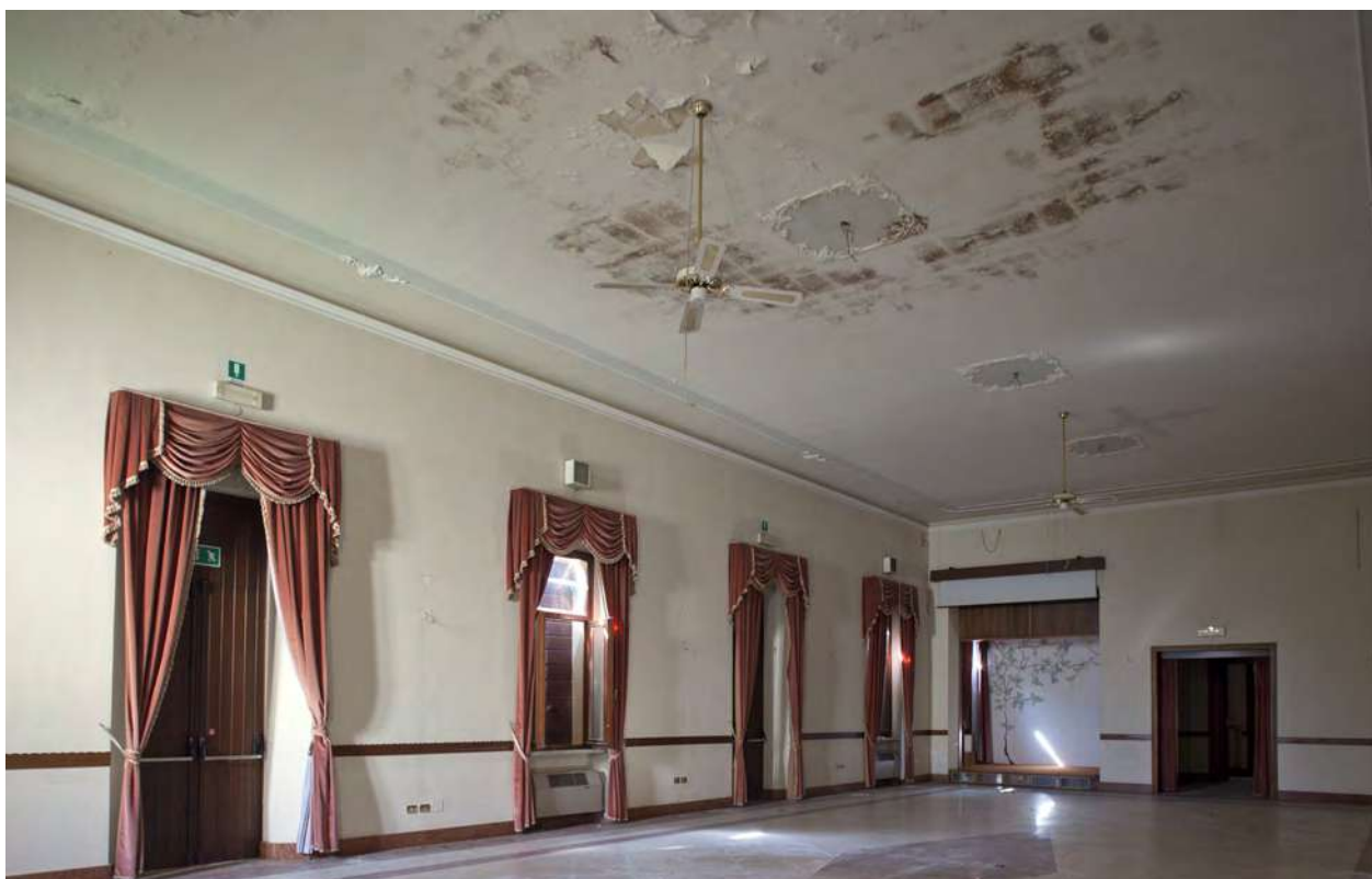
Immagine interno - Lato Est salone piano terra
