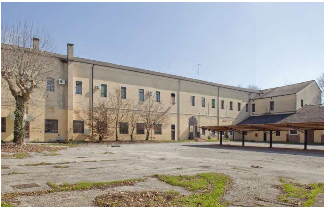
Immagine esterno - Prospetto Ovest
