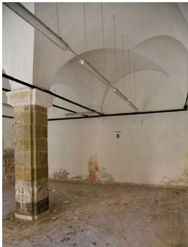
Immagine interno - Piano terra
