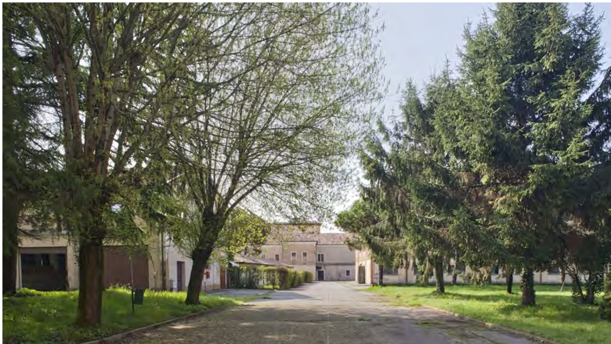
Immagine esterno - Prospetto Nord-Ovest
