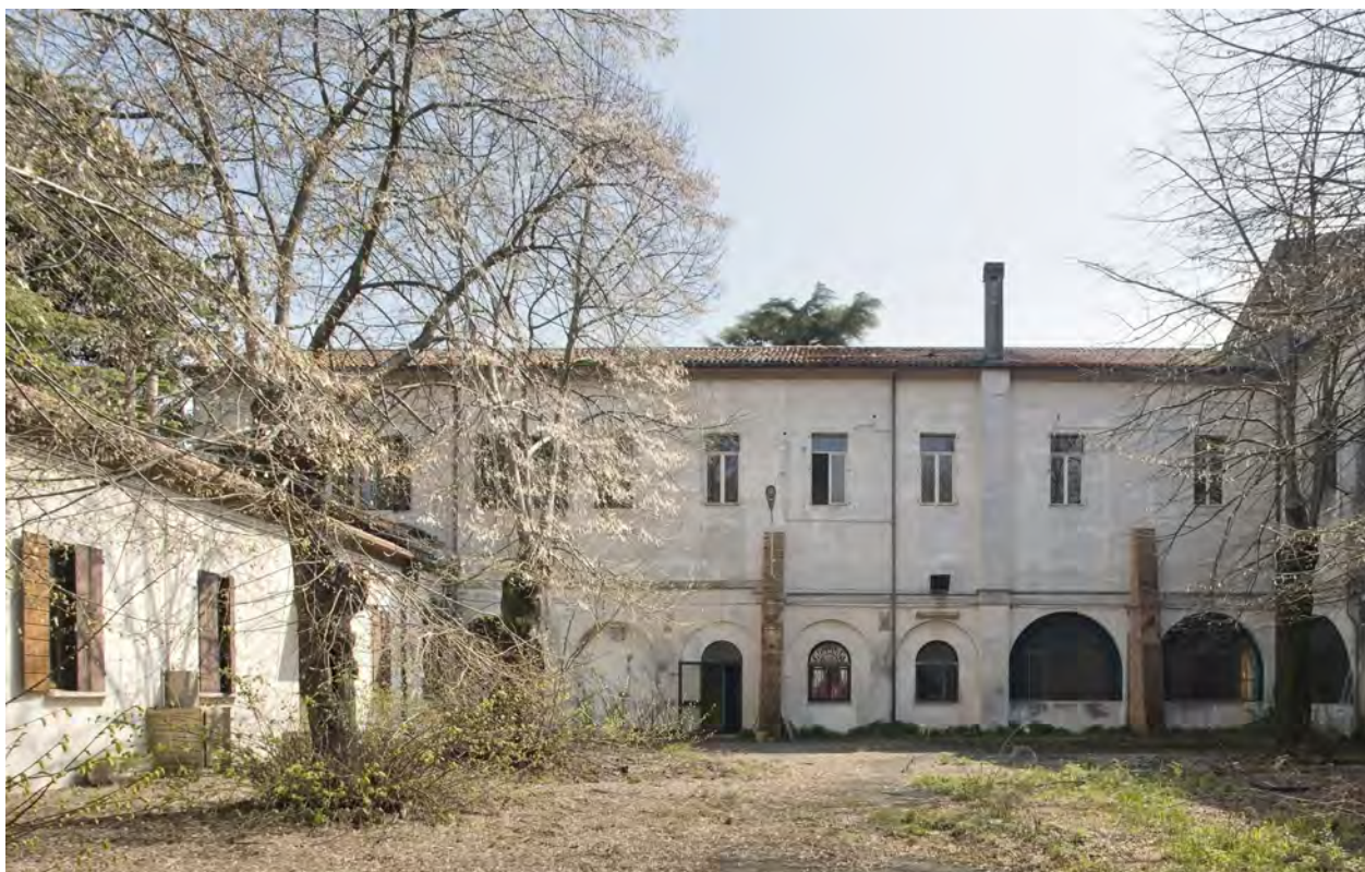
Immagine esterno - Prospetto Ovest
