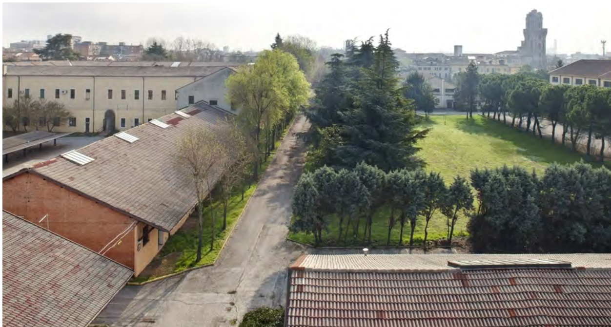
Immagine esterno - Vista aerea verso Est
