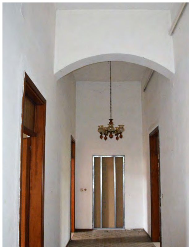
Immagine interno - Lato Est piano primo
