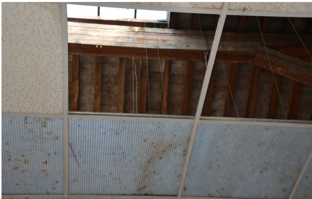
Immagine interno - Struttura copertura
