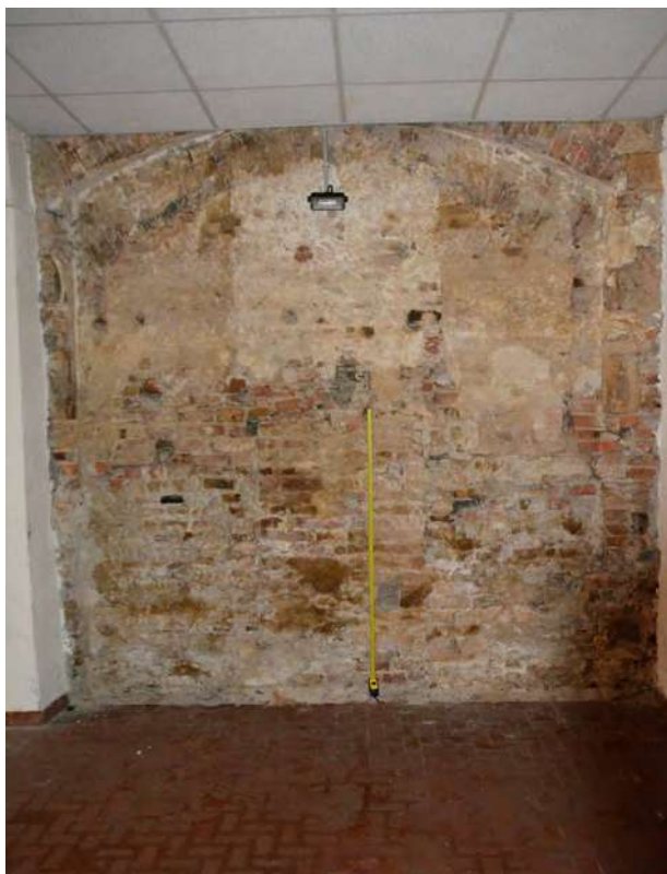
Immagini interno - Piano terra
