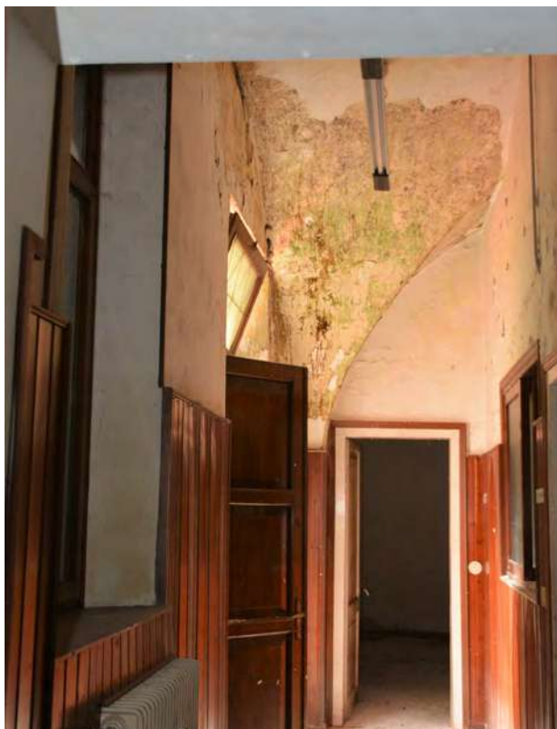
Immagine interno - Lato Ovest piano terra
