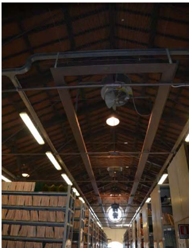
Immagine interno - Copertura
