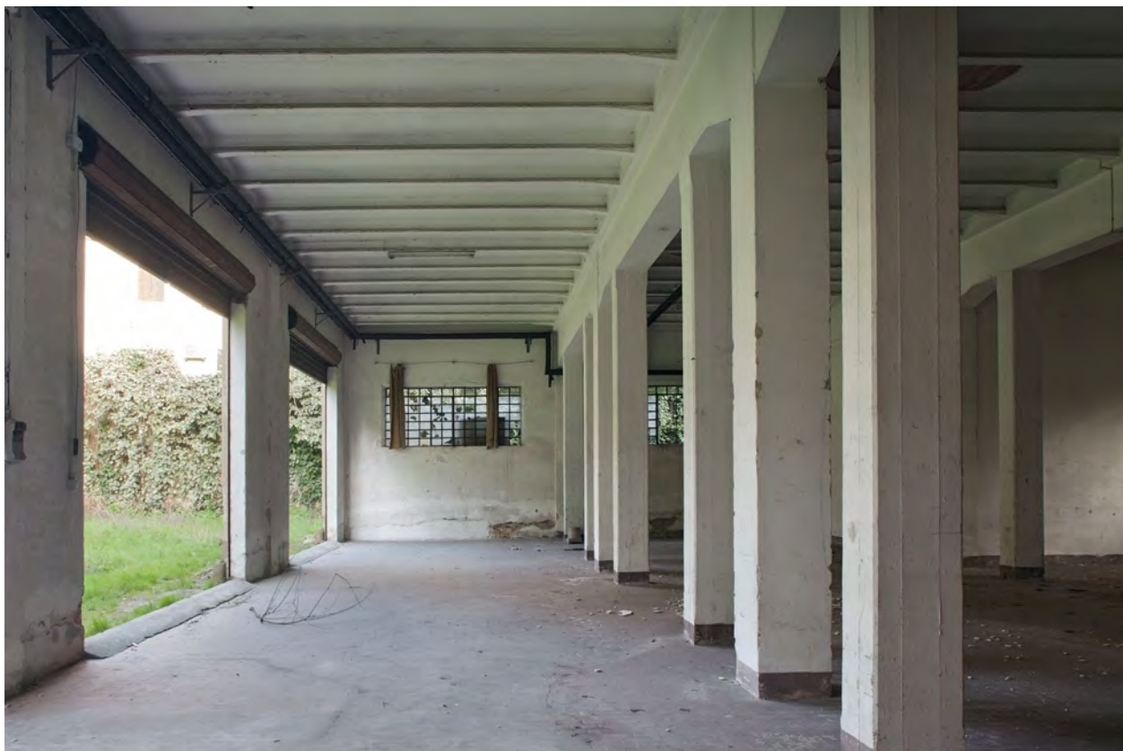
Immagine interno_Piano terra
