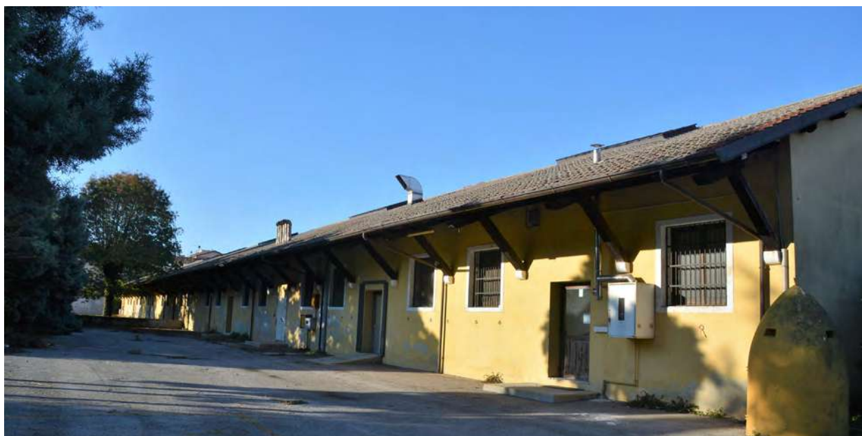
Immagine esterno - Prospetto Ovest
