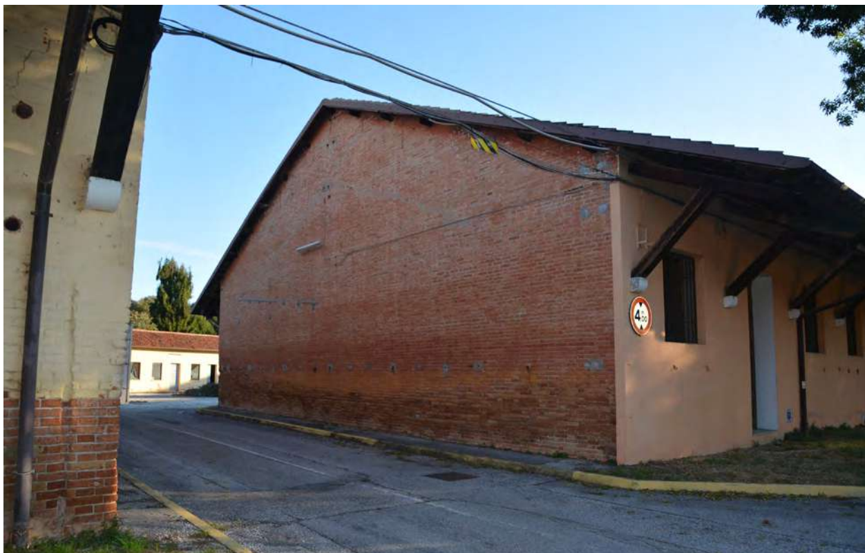
Immagine esterno - Prospetto Ovest
