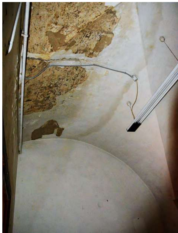
Immagine interno - Lato Ovest piano terra
