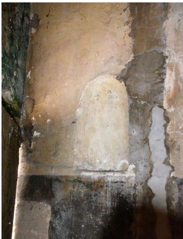
Immagine interno - Piano terra
