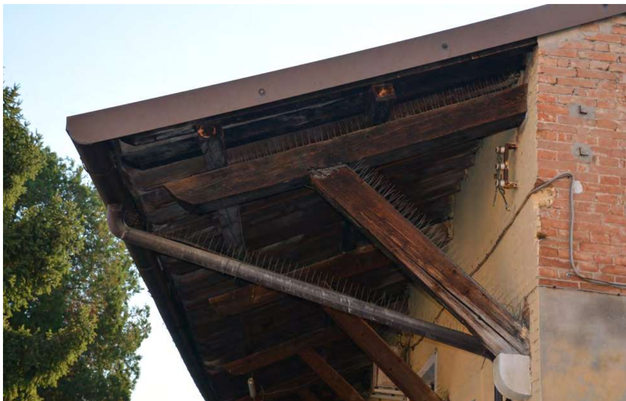
Immagine esterno - Dettaglio copertura
