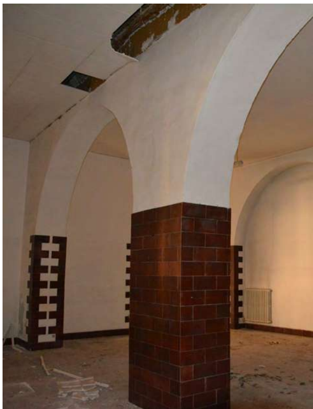
Immagine interno - Piano terra
