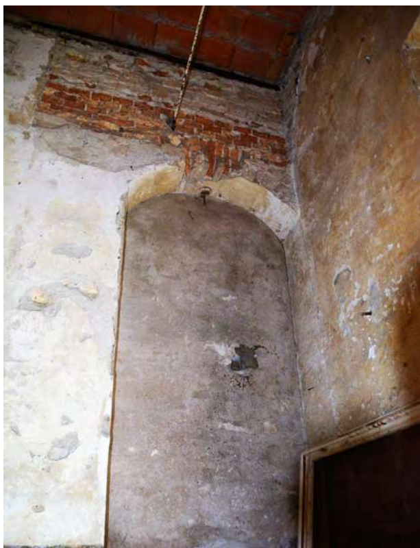
Immagine interno - Piano terra
