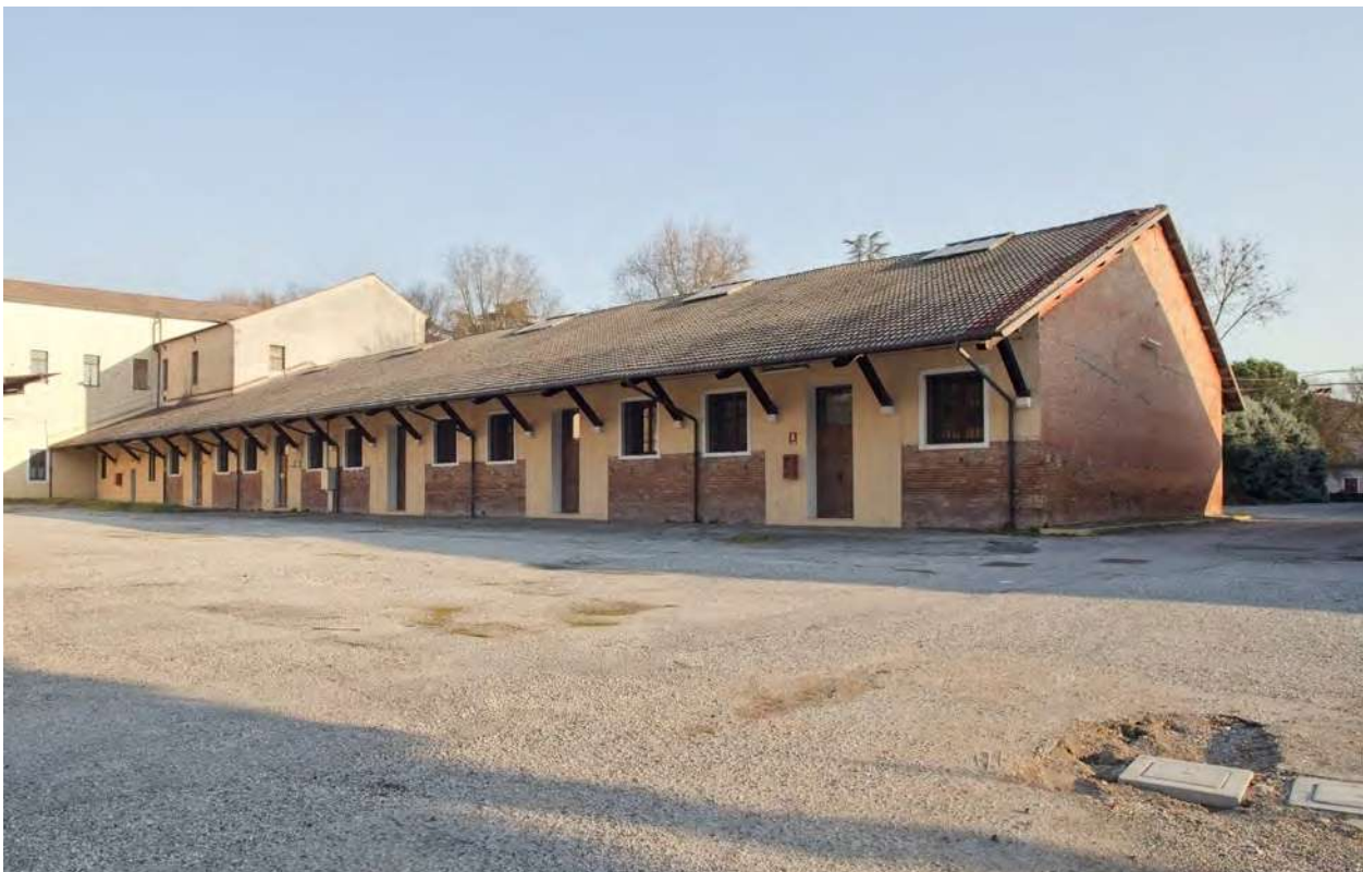
Immagine esterno - Prospetti Sud - Est
