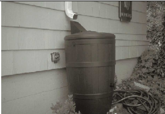
Accumuli alla base della grondaia
