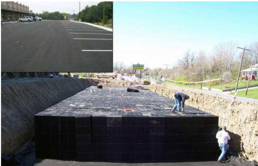
Figura 25- Cella modulare in materiale plastico in fase di montaggio
