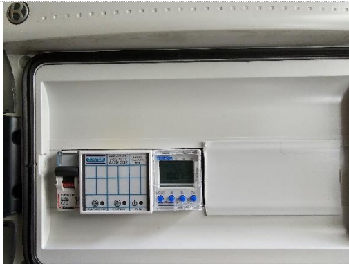
Centraline di regolazione in centrale termica
