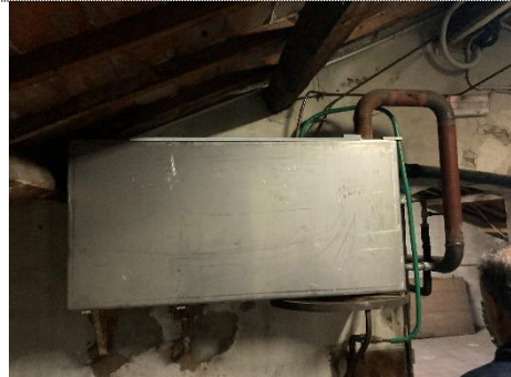
Vista vaso aperto nel sottotetto
