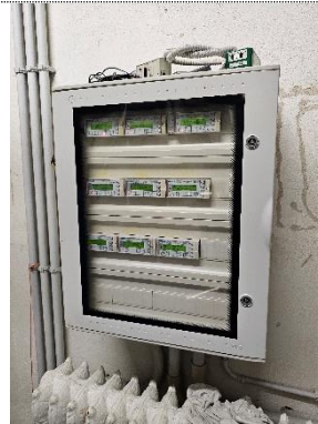
Centraline di regolazione nella sottocentrale principale
