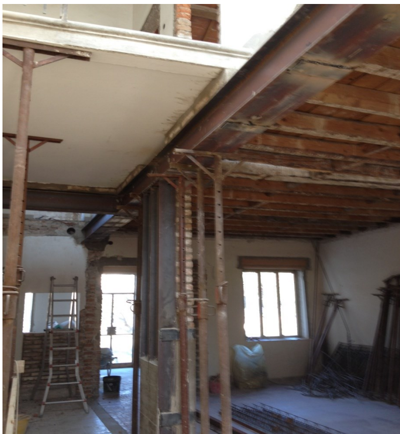
Strutture miste Muratura - Cemento Armato
