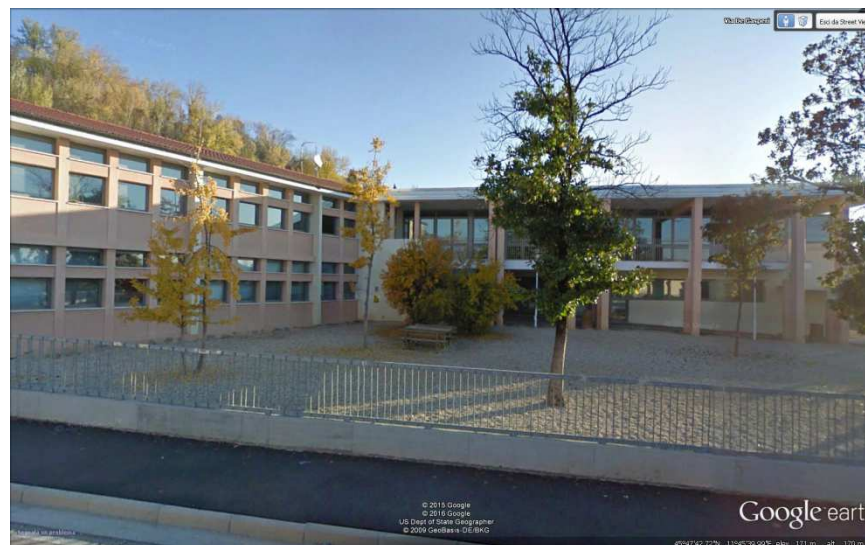
Nuovo Asilo Nido e Nuove Scuole Elementari .
