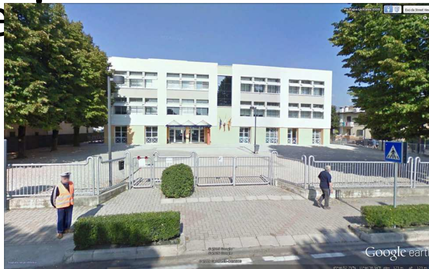
Ristrutturazione Scuole Elementari e Medie Esistenti.
