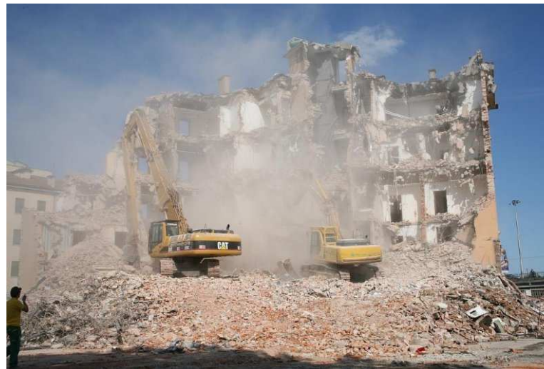
D.LL. CSE Demolizione edifici
