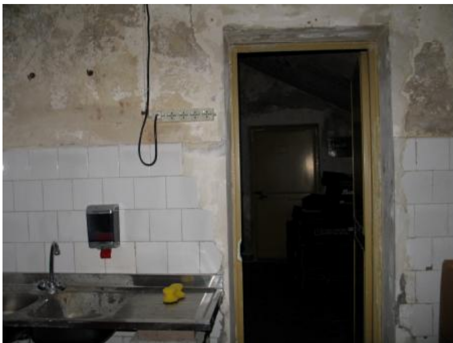
FOTO N° 23 – LOCALI DI SERVIZIO
