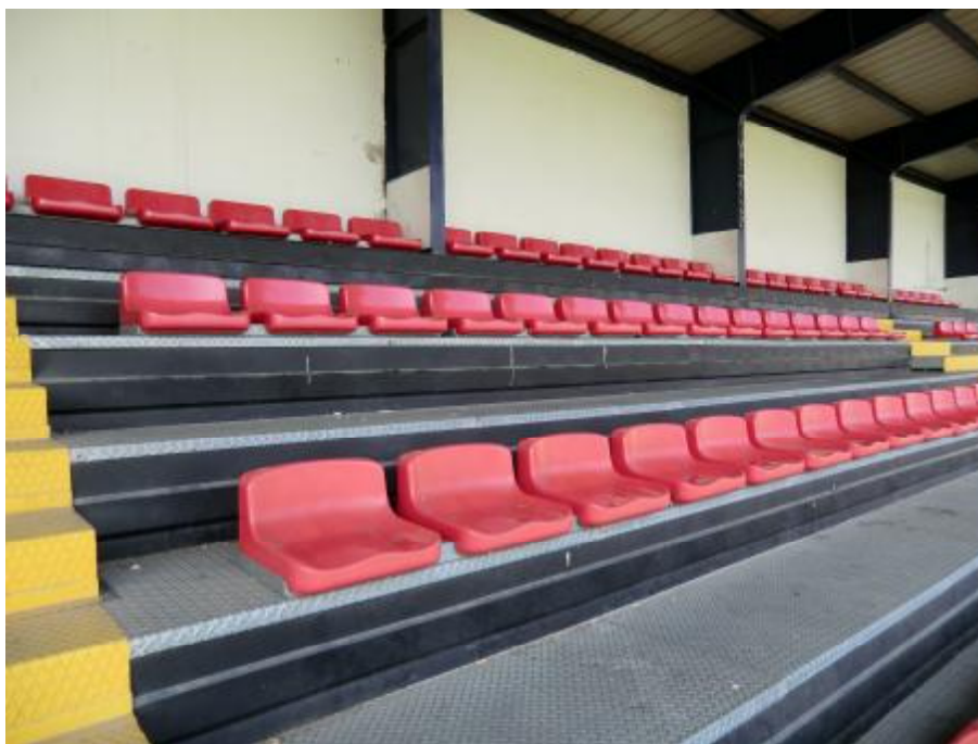
FOTO N° 7 – TRIBUNA OVEST CON SEDUTE
