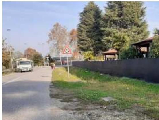
Via Latisana – canaletta di scolo
