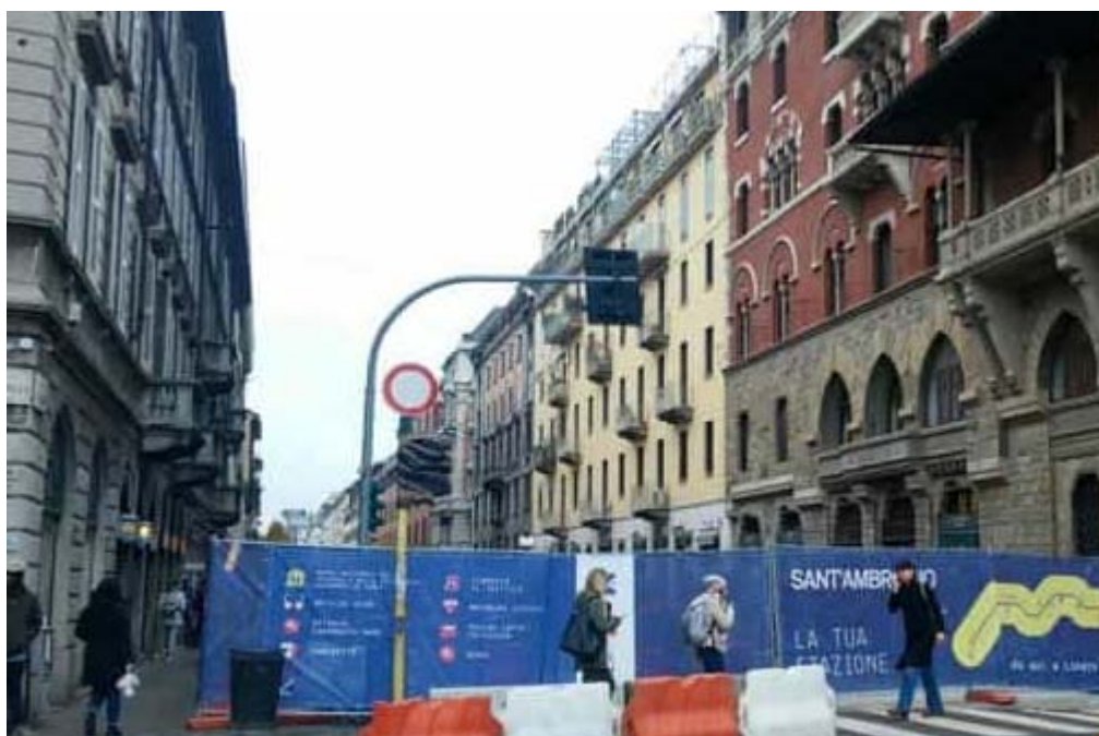
Figura 32_descrizione dei lavori in corso
