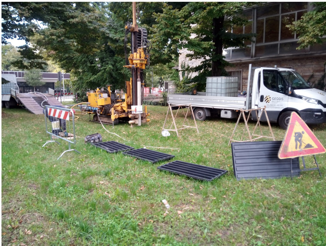
Fig. 3-Posizionamento sondaggio.
