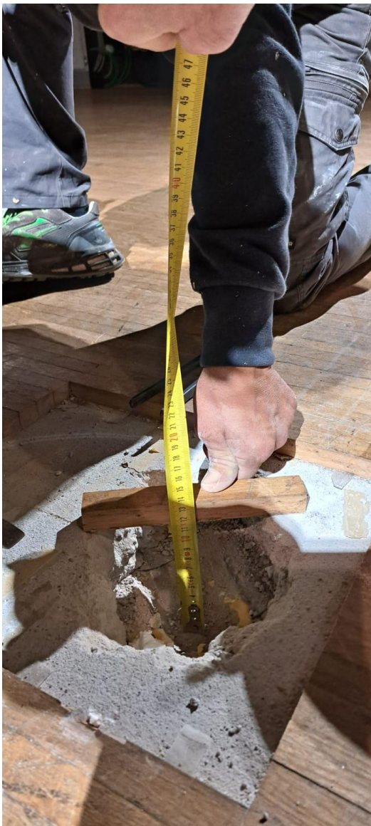
Foto 11 – Saggio su palco per demolizione massetto e pannello radiante
