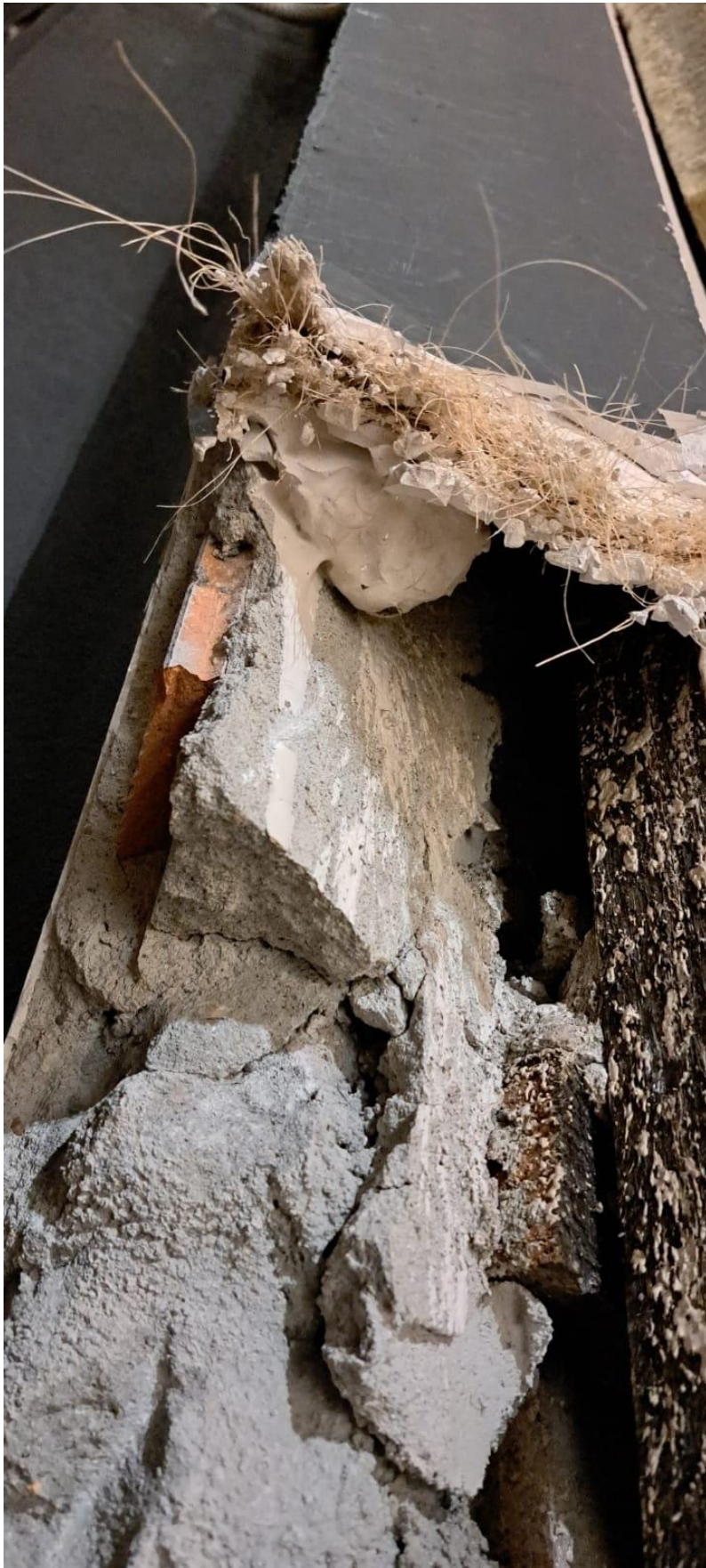
Foto 12 – Porzione di spigolo da demolire su proscenio torre scenica
