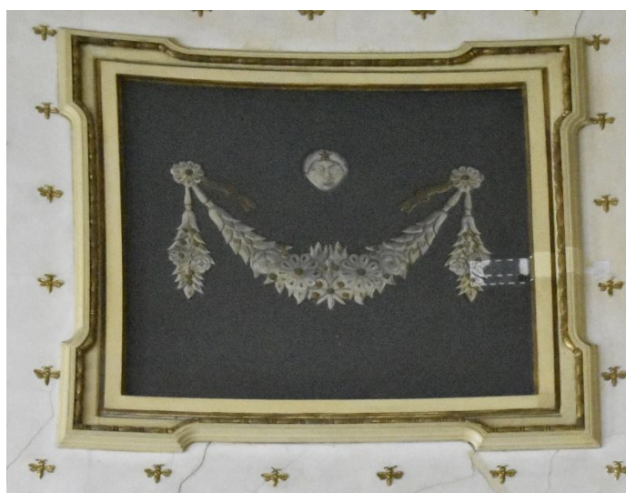
Figura 2-11 Cornice delle finestrelle con drappi a fondo nero.
