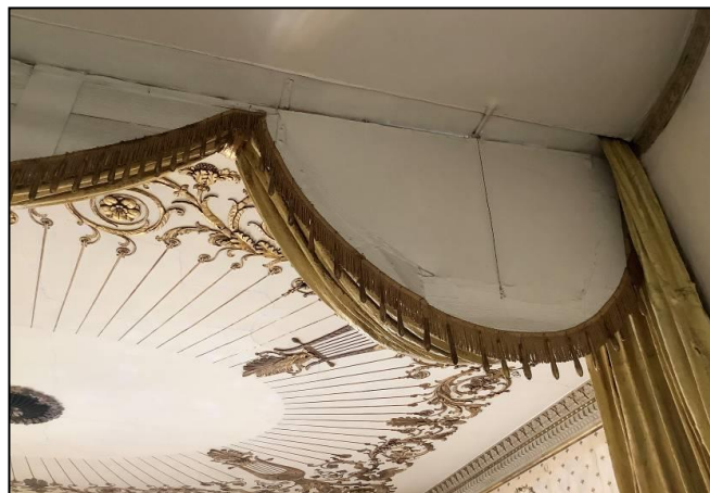
Figura 2-21 Palco, parte alta interna. Struttura di supporto al tendaggio in stucco. Evidente ripresa con aggiunta di pannellatura e stucchi grossolani.
