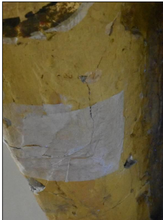
Figura 2-36 Finto sipario, velinatura di protezione passato intervento.
