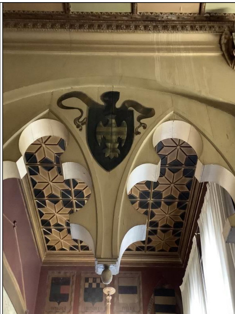
Figura 5-9 Medesimo particolare visto dalla Sala Gotica.
