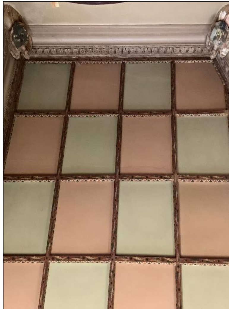
Figura 5-2 Scorcio del soffitto a cassettoni sala gotica. I riquadri, attualmente di colore arancio e verde a scacchiera, sono delimitati da un cordolo decorato.
