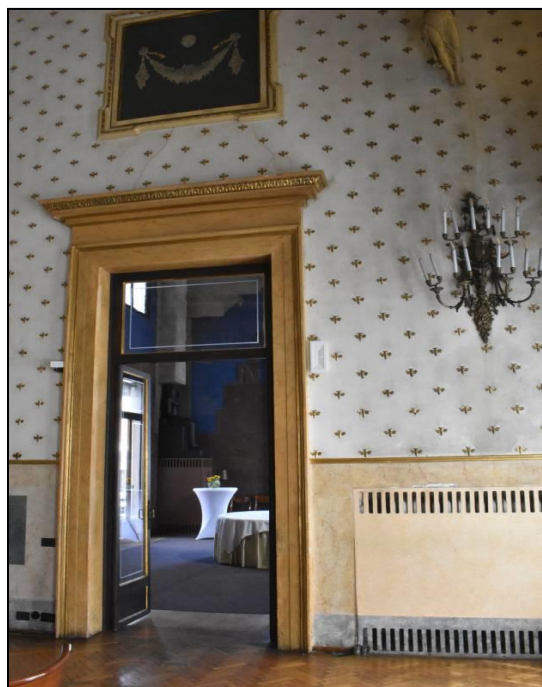
Figura 2-2 Porte interne con cornici e trabeazioni a finto marmo e cornici dorate. Infissi a doppia anta nella parte inferiore e parte superiore a vetro unico fisso.
