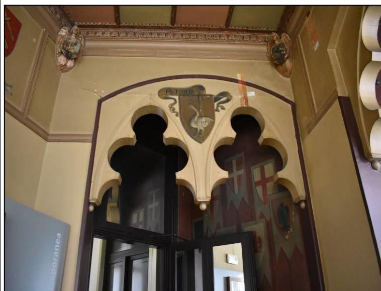
Figura 5-10 Particolare della sagoma ad ogiva e trilobata inserita nell'intradosso dell'apertura che dalla sala gotica immette in una sala adiacente.
