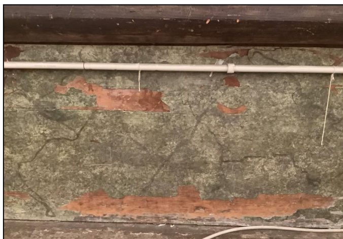
Figura 2-19 Parte bassa del palco, interno. Decorazione a finto marmo su toni grigi con cadute che mettono a vista livello sottostante di colore terra bruciata.
