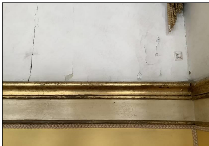
Fig. 2-16 Particolare cornice in legno dorata che corre lungo tutta la sala a 160 centimetri dal pavimento. Sempre parte bassa del palco con sfogliature e fessurazioni.
