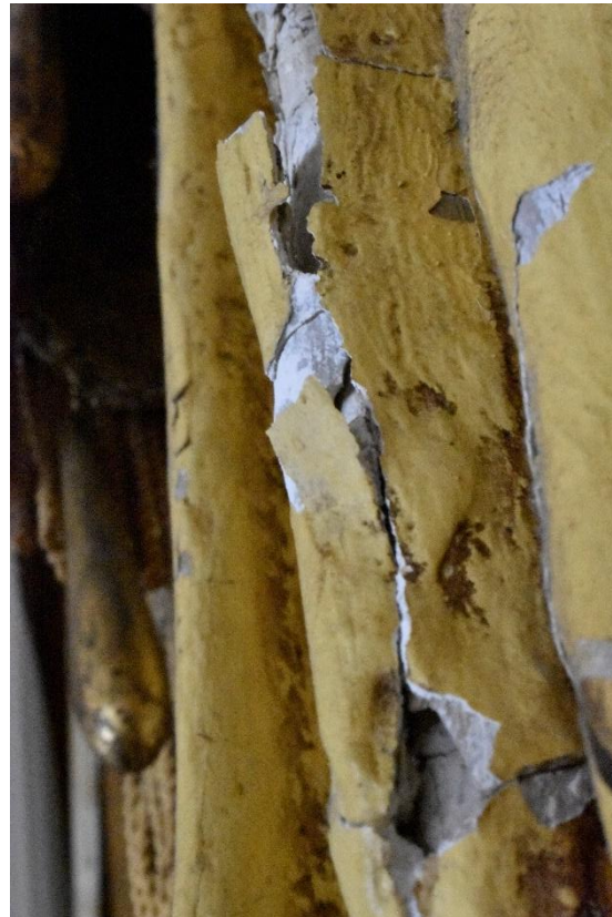
Figura 2-35 Finto sipario, frammentazione del gesso perché molto più rigido della tela di supporto.
