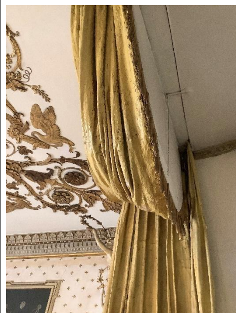
Figura 2-32 Finto sipario, particolare di pesanti riprese in stucco del panneggio del festone laterale.
