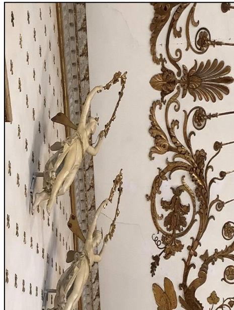
Figura 2-24 Le sculture sono appese tramite un elemento metallico quadrangolare che si inserisce in due anelli infissi nella muratura.
