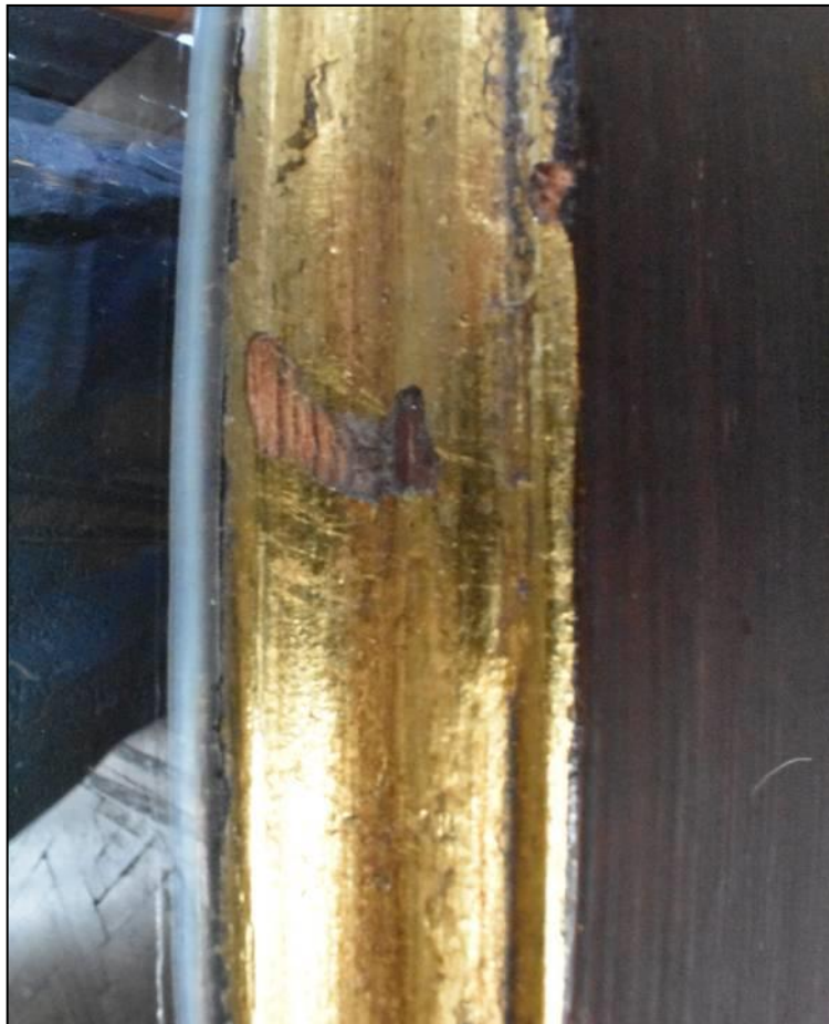
Figura 2-7 Fenomeni di contrazione della superficie dorata nei listelli delle cornici delle porte
