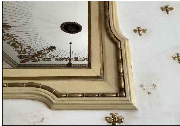
Figura 2-12 Particolare della cornice delle specchiere con profilo sagomato e intaglio a fuseruole.
