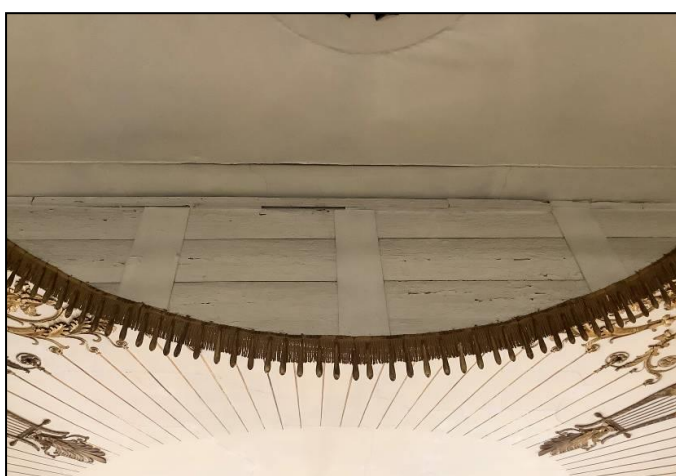
Figura 2-20 Palco, parte alta interna. Struttura di supporto al tendaggio in stucco. Sottili liste di legno connesse tra loro e sospese tramite elementi ad esse in metallo.
