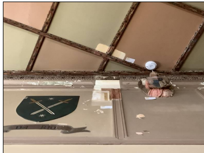
Figura 5-5 Particolare di saggi di pulitura che mettono a vista uno strato sotto l'attuale, monocromo e di colore beige.
