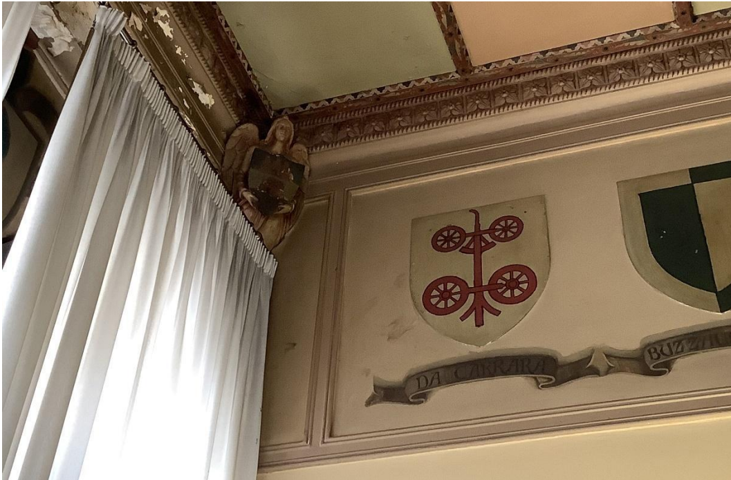
Foto II.5.30 – Particolare della porzione sommitale delle pareti, con gli stemmi di nobili famiglie padovane entro specchiature rettangolari con sottili cornici modanate di stucco. Si noti anche l'angelo che sorregge un ulteriore stemma e la cornice di raccordo con il controsoffitto
