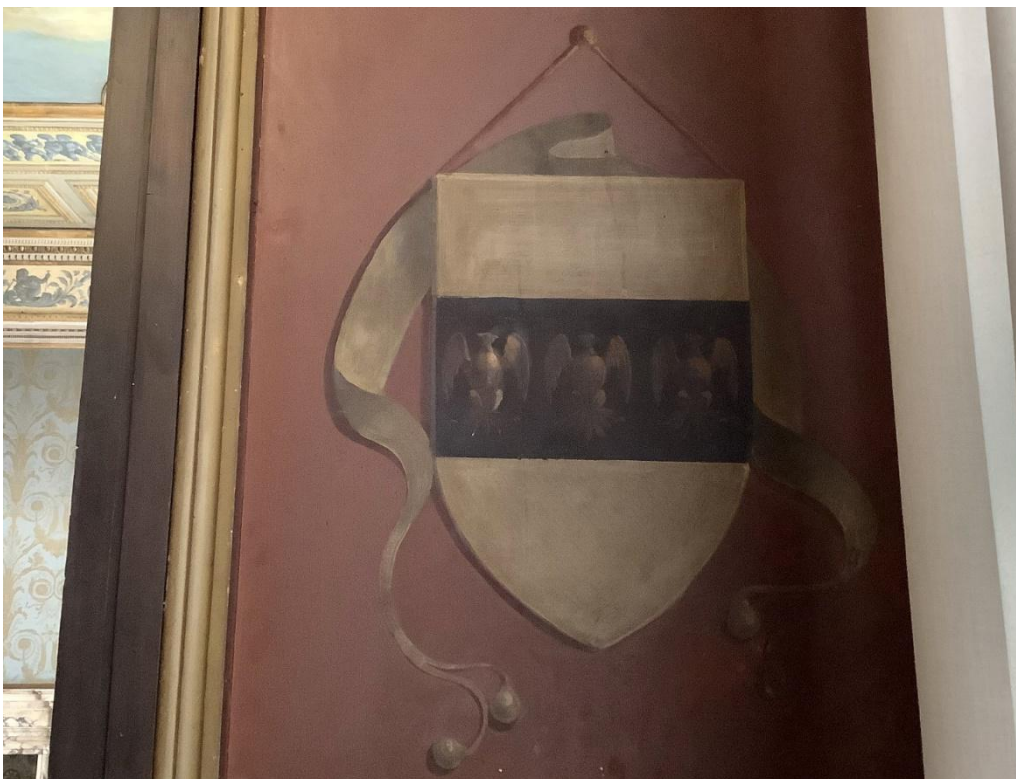
Foto II.5.7 – Vestibolo della Sala Gotica: particolare di uno degli scudi dipinti a trompe l'oeil, “appeso” alla parete con una borchia e un laccetto. La decorazione, sicuramente non originale, riprende comunque le decorazioni con imitazione di apparati effimeri effettivamente attestate nel XV e XVI secolo
