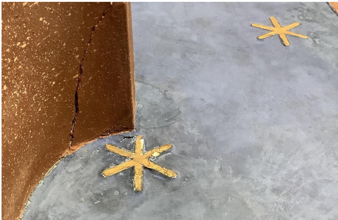
Foto II.3.36 – Sala Egizia, particolare di due stelle di stucco dorato della decorazione sulle pareti
