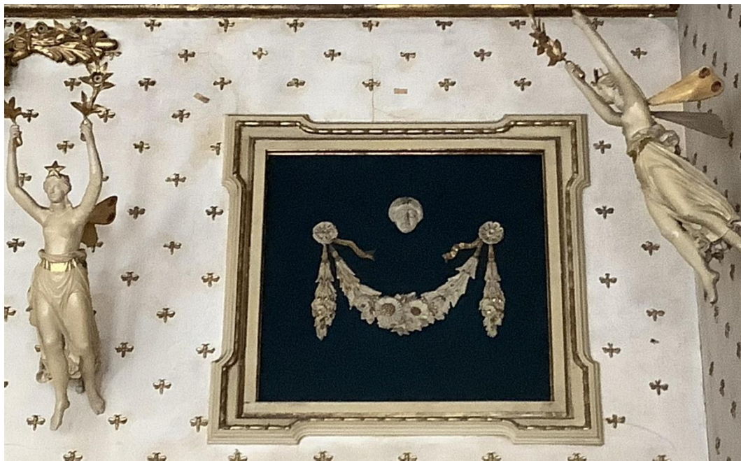
Foto II.2.8 – Sala Rossini, particolare del pannello di legno di una delle bucaure nella porzione superiore della parete con il palchetto dell’orchestra: il festone e la testa umana sono eseguiti a rilievo
