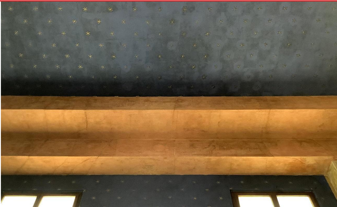
Foto II.3.20 – La porzione centrale di uno degli architravi doppi su uno dei lati lunghi della Sala Egizia, probabilmente costituiti da canniccio intonacato: si noti la presenza di una disco solare alato
