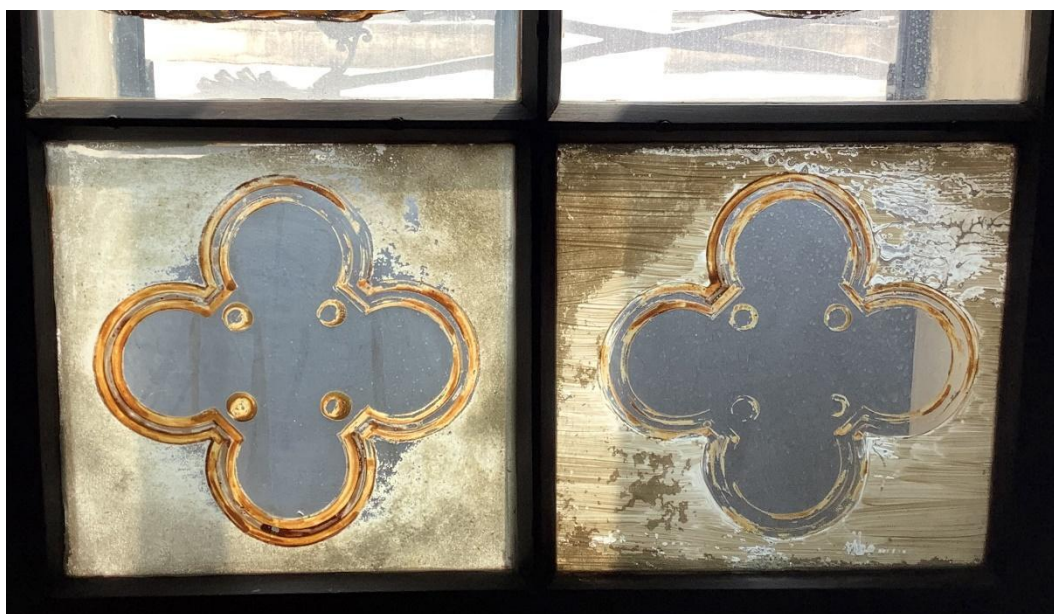
Foto II.5.43 – Particolare dei quadrilobi (di ottima qualità esecutiva e probabilmente riferibili agli interventi del 1894) sotto alle figure degli uomini d’arme della Foto II.5.42 : lo sfondo del quadrilobo destro mostra una ripintura marrone sull’originaria coloritura bianca
