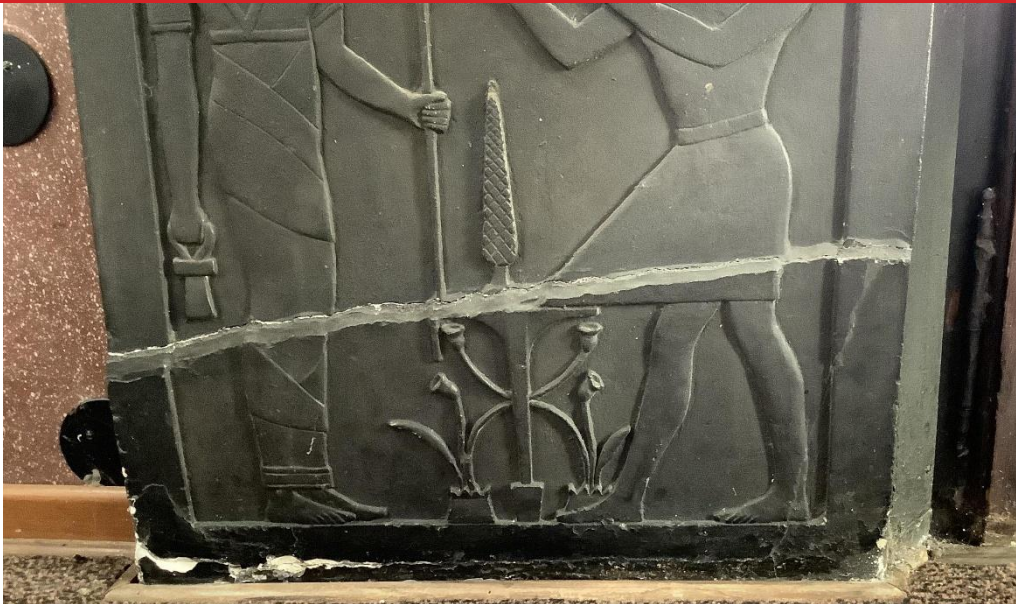
Foto II.3.44 – Sala Egizia, particolare di uno dei bassorilievi della cornice della grande porta-finestra che immette sulla terrazza esterna: si notano un’evidente fessurazione e spostamento della porzione basamentale della cornice, distacchi, scagliature e lacune della pellicola pittorica superficiale
