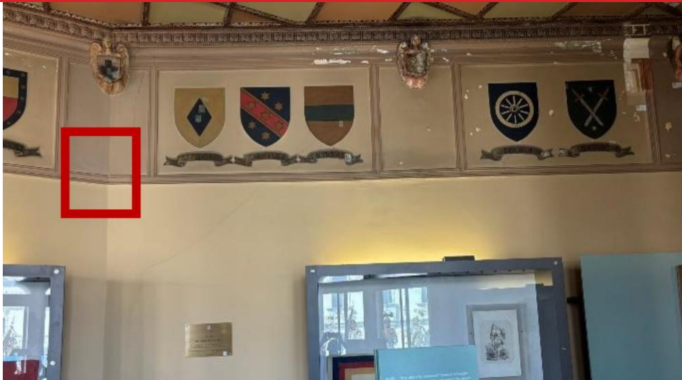
Foto II.5.70 – Localizzazione del Saggio GTC_S4, eseguito nel settembre 2025 a cura della RED Studio in corrispondenza del fregio sommitale nel punto di giunzione tra le pareti ovest e nord-ovest della Sala Gotica
