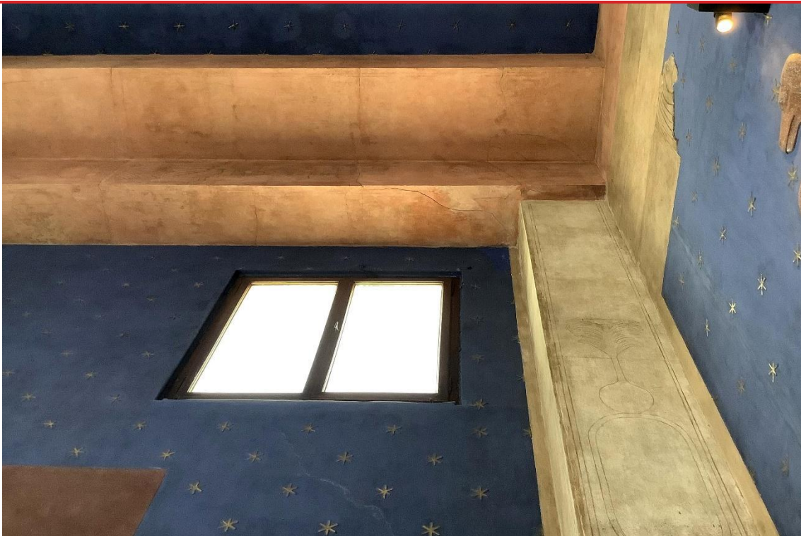
Foto II.3.18 – Sala Egizia: vista d'insieme di uno dei falsi pilastri angolari, con sovrastante architrave doppio
