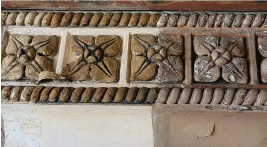
Foto II.5.34 – Particolare della cornice di stucco di raccordo con il controsoffitto: alcuni saggi stratigrafici hanno rivelato la presenza di alcune coloriture riferibili a una fase di decorazione precedente
