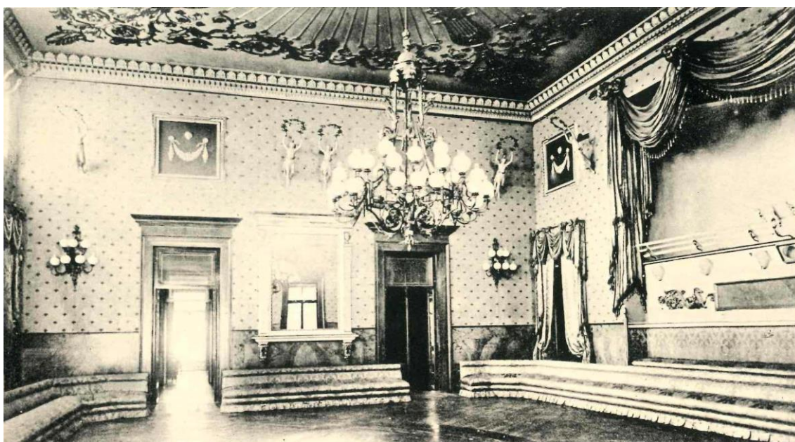
Fig. I.2.2 – La Sala Rossini in una foto del 1906: si intravedono il pavimento originario in parquet (che riprendeva il motivo ellittico sugli stucchi del controsoffitto) e la decorazione delle pareti con le api di lamierino dorato ( Foto II.2.13 e II.2.18 ). Tratta da L. Puppi, Il Caffè Pedrocchi di Padova , op. cit., Tav. 140.
