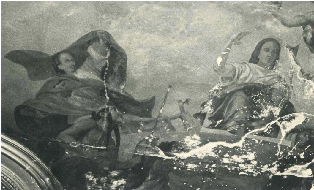
Fig. 1.4.4 – Sala Rinascimentale, particolare de La Civiltà dispensa al mondo i suoi doni in una foto del 1977-1979 (tratta da L. Puppi, Il Caffè Pedrocchi di Padova , op. cit., Tav. 152) con estese lacune nella pellicola pittorica e fessurazioni già risarcite (ma non ancora reintegrate) in seguito al cedimento parziale del controsoffitto. Il volto (e soprattutto i capelli) della Civiltà appaiono inoltre parzialmente modificati.
