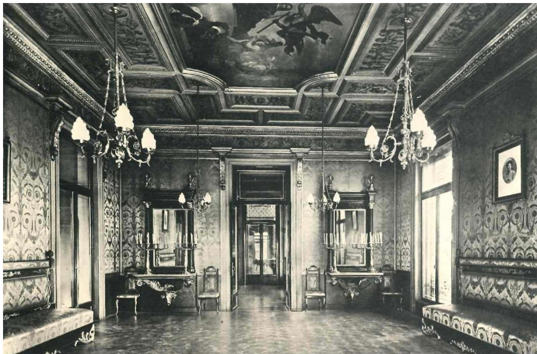
Fig. I.4.2 - La Sala Rinascimentale in una foto del 1930 circa, tratta da L. Puppi, Il Caffè Pedrocchi di Padova , op. cit., Tav. 149: è già presente l'attuale pavimento in parquet, con un motivo a cubi prospettici, mentre manca il caminetto nella parete tra le finestre ( Foto II.4.4 e II.4.35 ), inserito nel 1935.
