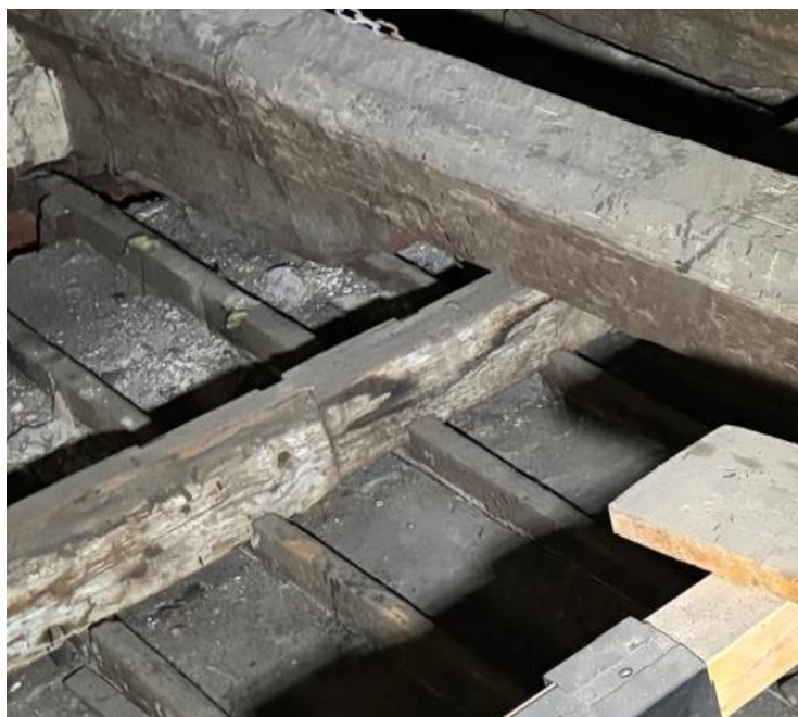
Figure 6 - Tacche visibili nell'orditura primaria del plafone
