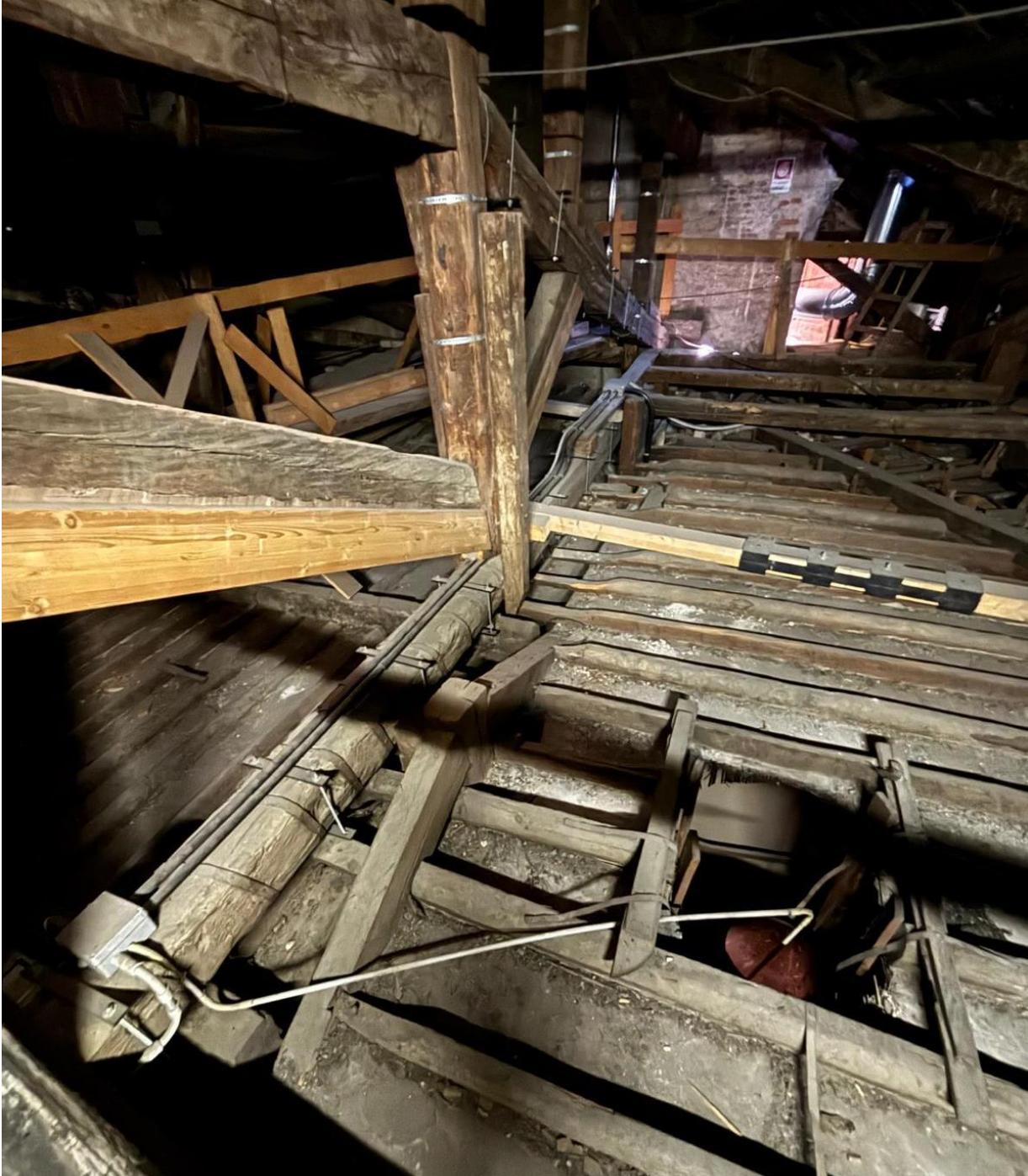
Figure 7 - A sinistra l'incavallatura CP5, il foro di aspirazione dei fumi del lampadario del palchetto ad esedra della Sala Rossini: emerge dal plafone la punta della capriata a sostegno del sipario del palchetto della Sala Rossini.
