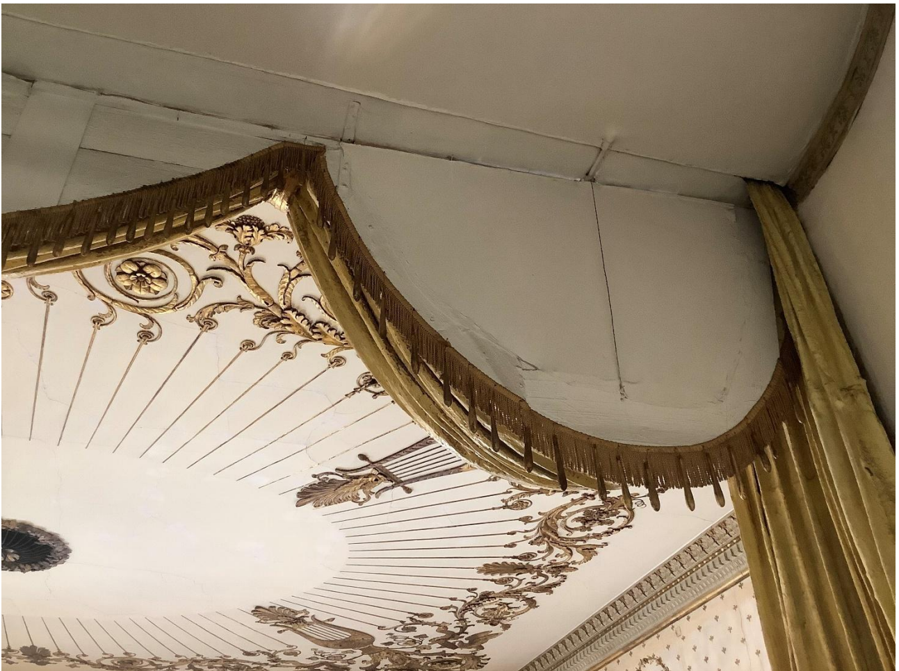
Figure 16 - Il retro del sipario del palcoscenico con il sistema originale ad assi (a sx) e successivi pannelli di integrazione successiva (a dx) e probabile ancoraggio sommitale alla capriata
