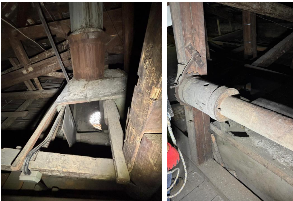
Figure 15 - A Sx la canna fumaria per lo sfiato dei fumi dell'antico lampadario alimentato a gas e la trave a sostegno del lampadario che poggia direttamente tra monaco e saetta. Sotto la canna fumaria si intravede la griglia di areazione con forma a rosone ove, al centro, è posizionato il lampadario; a Dx l'argano di sollevamento del lampadario
