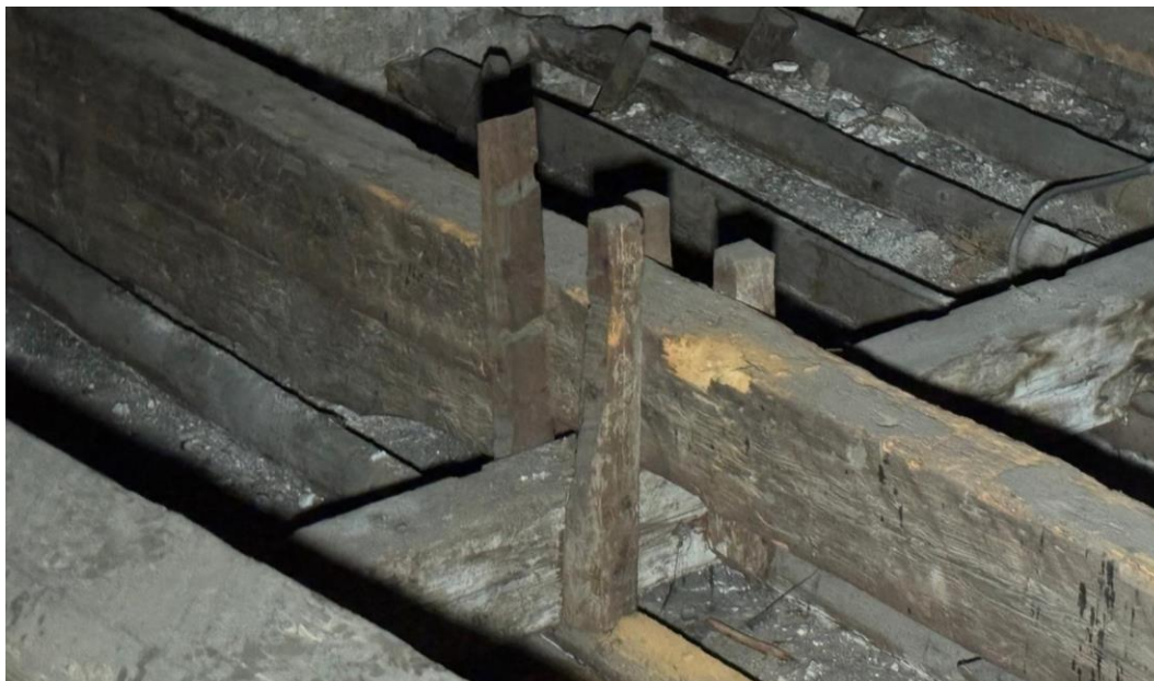
Figure 13 - Sistema di pendinatura.
