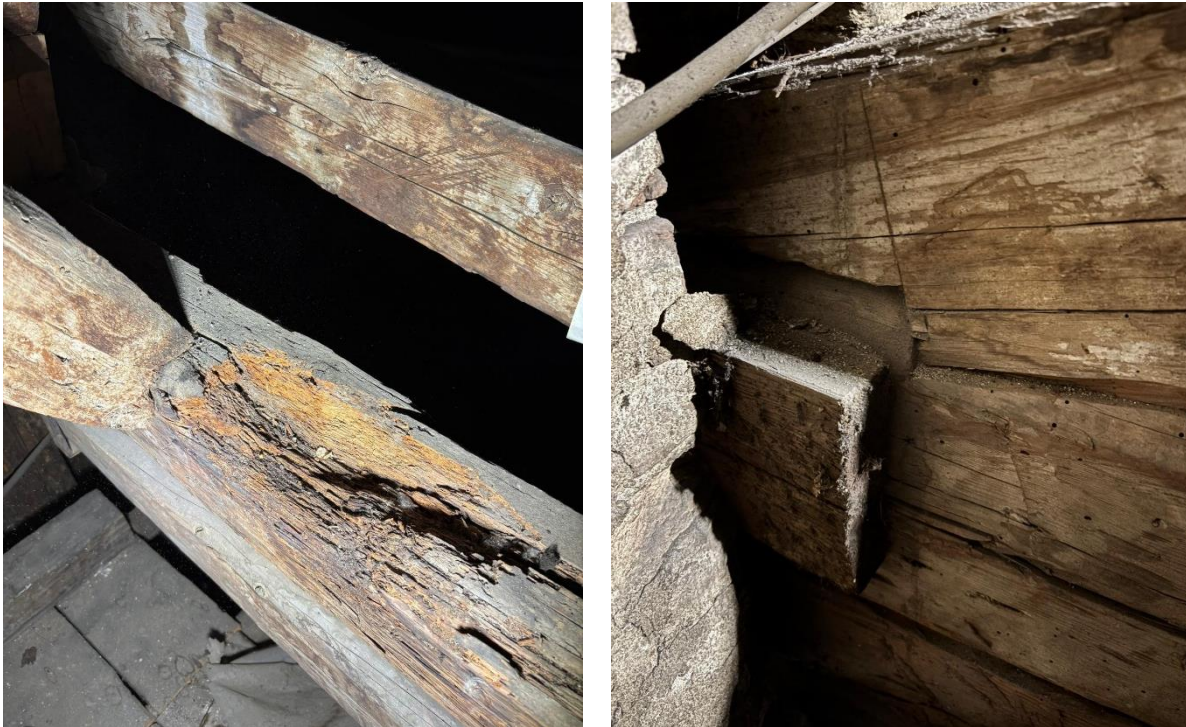
Figure 19 – A sx attacco xilofagi del materiale ligneo; a dx nodo tra puntone e catena CP7 lato sud
