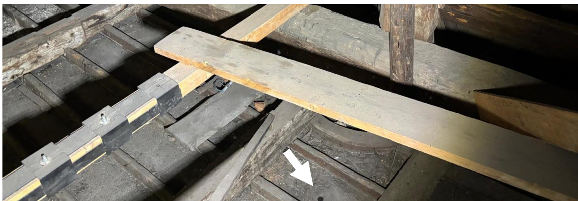
Figure 10 - Probabile perforazione per alloggiamento del sistema di illuminazione visibile nelle foto degli anni '80.
