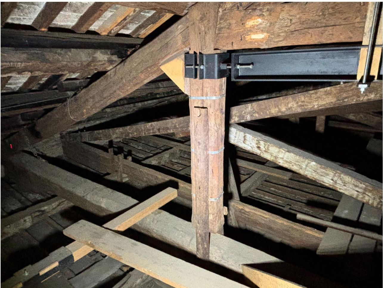
Figure 5 - Incavallatura CP5 – interventi di restauro strutturale del 2007.
