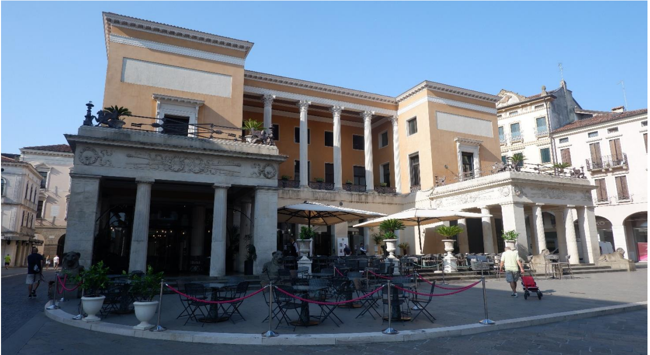
Figura 1 - Prospetto nord del Caffè su piazzetta Pedrocchi.
