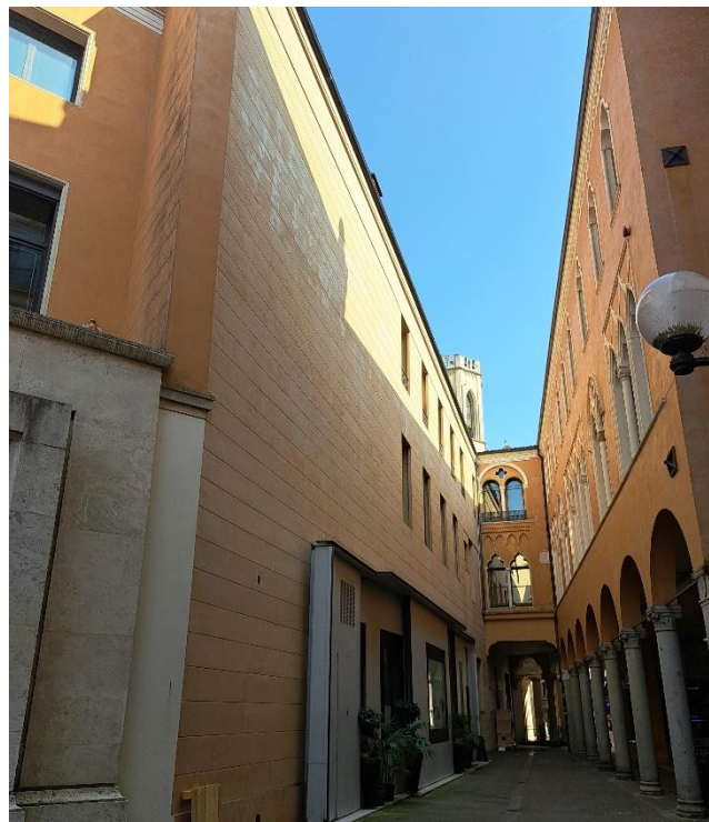
Figura 4 - Prospetto ovest dell'edificio sul vicolo Cappellato Pedrocchi.
