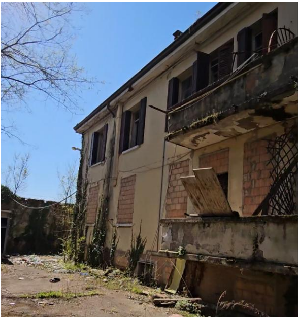
19. Edifici in fase di demolizione
