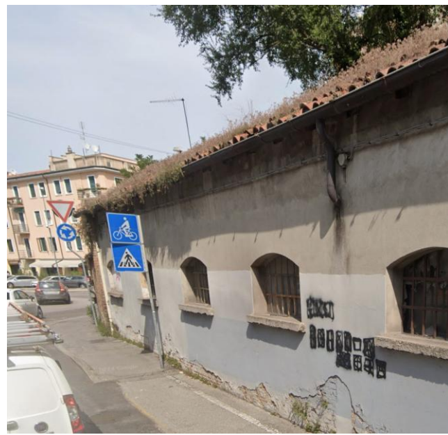
20. Edificio in fase di demolizione confinante con Via Orsini
