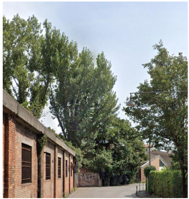
10. Via Orsini e gli edifici della caserma in fase di demolizione
