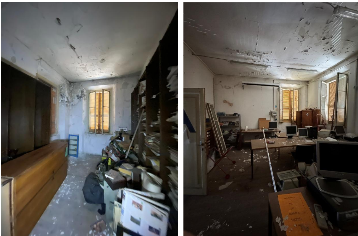
Figura 17 – Immagini controsoffitti in arelle
