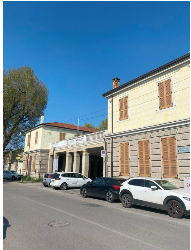
2 Vista dell'edificio da via Cornaro
