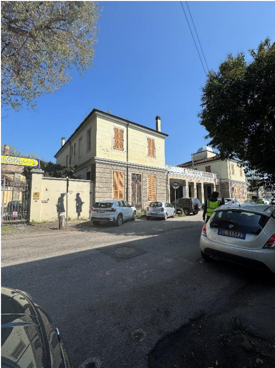
3 Vista dell'edificio da via Cornaro.
