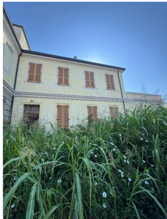
6 Vista dell'edificio da via Cornaro
