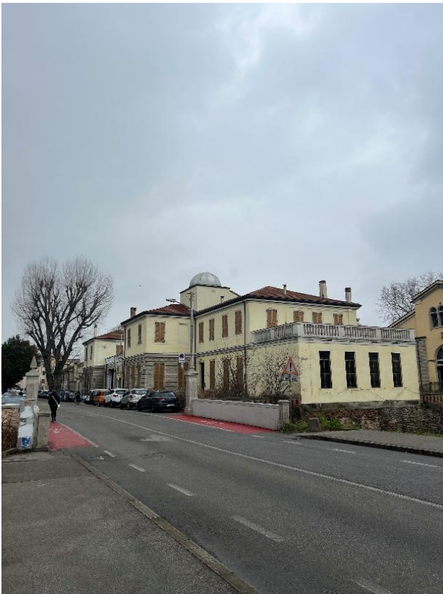
1 Vista dell'edificio da via Cornaro
