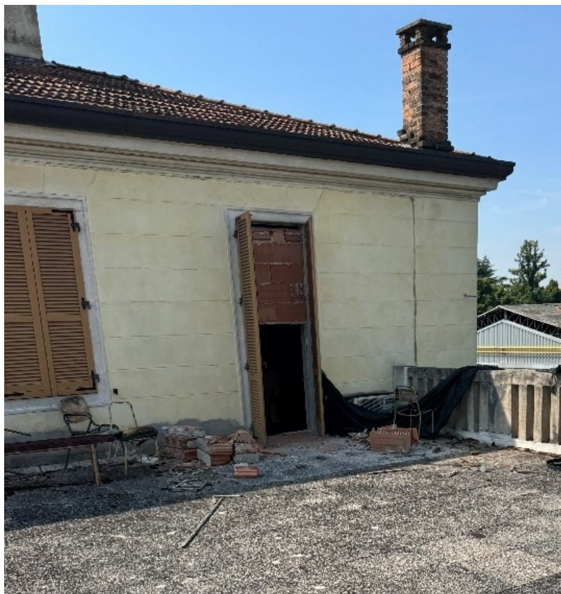
Figura 40 – Foto manto di copertura edificio B.
