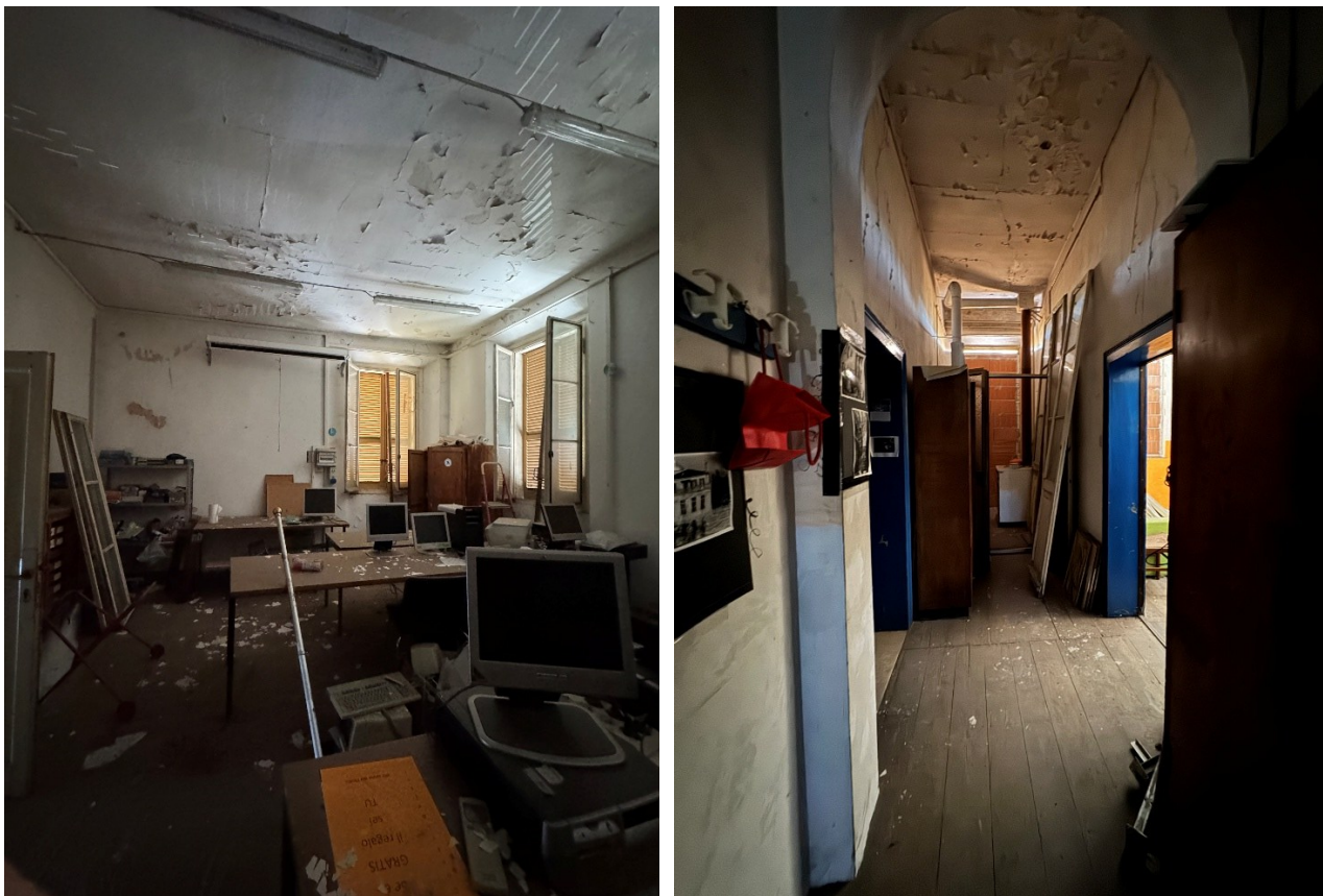
Figura 33 – EDIFICIO B – Immagini spazi interni.
