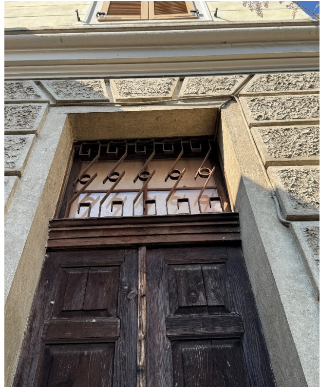
Figura 20 – Portoni di ingresso
